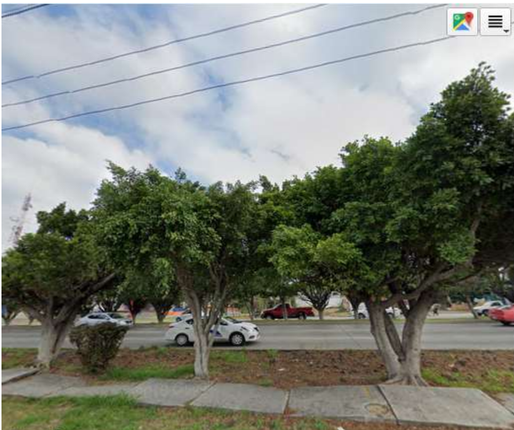
Figura 13. Representación del daño del arbolado público urbano a la carpeta asfáltica en las banquetas.
