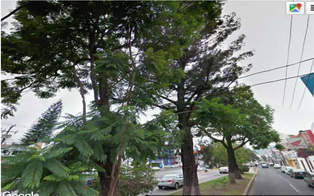
Figura 14. Representación del daño del arbolado público urbano a las redes aéreas.
