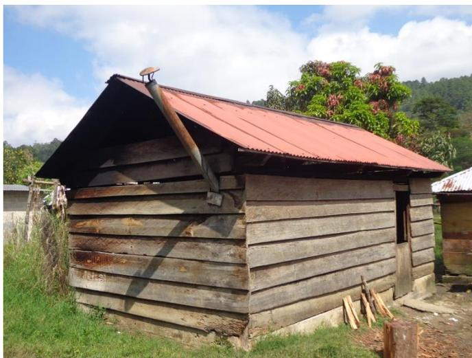
Figura 51. Cocina elaborada con madera de ocote y techo de lámina.
