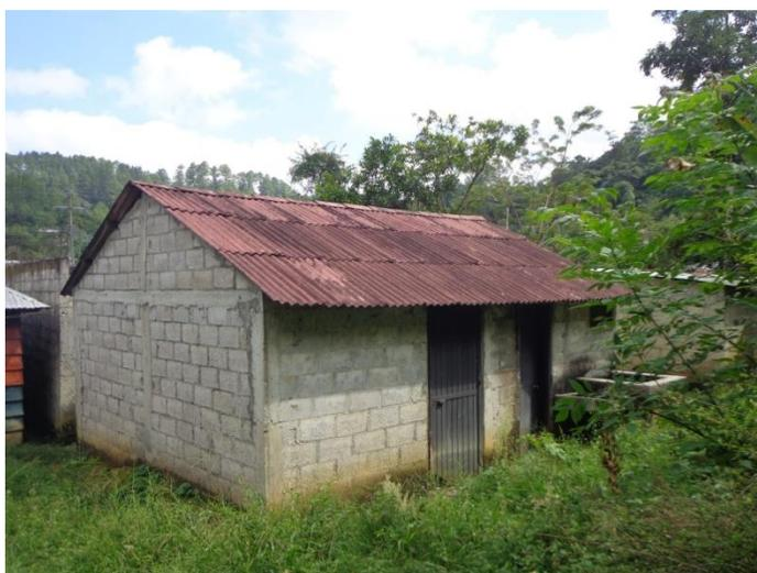
Figura 52. Vivienda construida con block y láminas galvanizadas.
