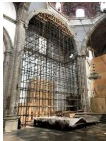
Imagen 1.2 Vista Interior de la nave del Templo de Santa Catarina con andamios (2020)
