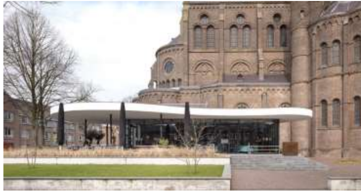
Imagen 4.1 Fachada lateral (antiguo presbiterio y nuevo restaurante)
