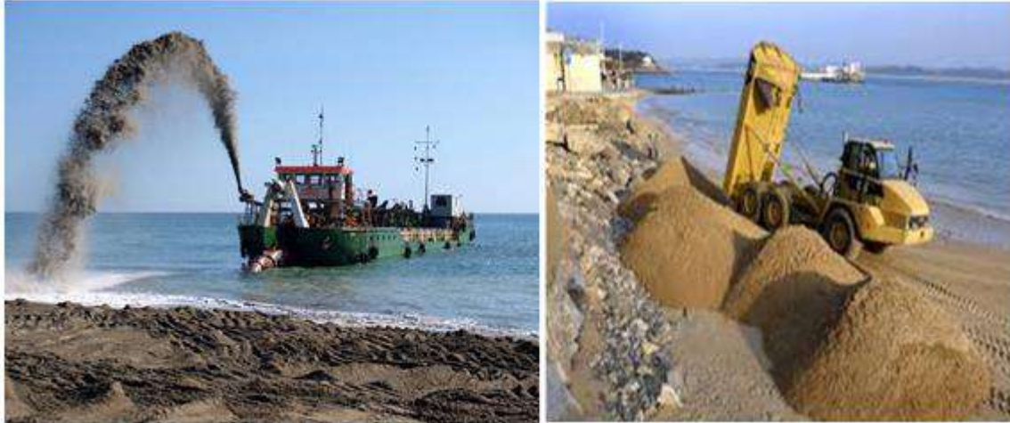
Figura 5. Ejemplo de relleno de playa (imagen obtenida de (Pranzini, Wetzel, & Williams, 2015 .pág.453).
