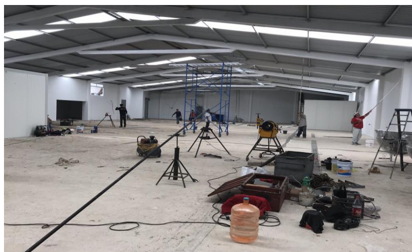
Figura 4.9. Labores de construcción de la nueva nave industrial de Nopimor
