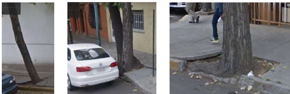
Imagen 13, 14 y 15. Representa las banquetas reventadas por la vegetación del lugar sobre la calle Nogal. Fuente: Elaboración propia con imágenes obtenidas en Google Maps Street View.
