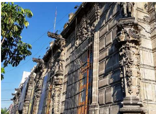
Imagen 4. Vista de la Casa de los Mascarones actual. (2019) Fuente: The City https://thecity.mx/venues/casa-de-los-mascarones/
