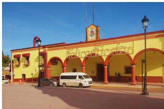
Fotografía 6 . Edificio del gobierno municipal
