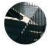
Elementos secundarios metálicos. Se busca verticalidad.
