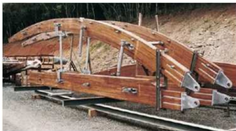
Foto 9. Pares de vigas laminadas para sistema de fachada. Pinterest (s.f.).
