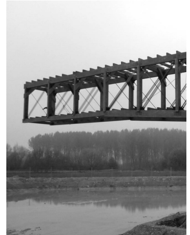
Proceso de construcción mirador.
