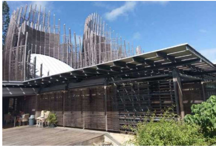
Foto 7. Se observa estructura de acero en crujía principal. Samar (2019).
