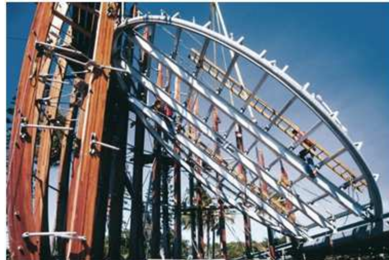
Foto 8. Estructura cabaña. Se observan los pares de vigas y la estructura de la cubierta en acero. RPBW (1991-1998).
