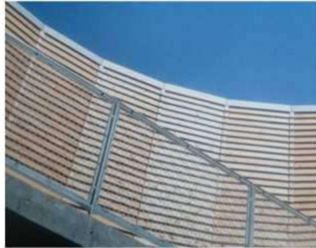
Foto 11. Tinglado en fachada interior. Jodidio (2015).
