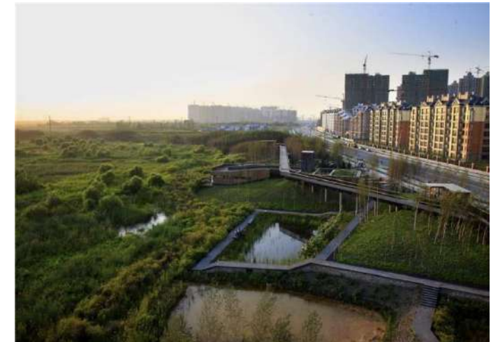
Foto 19. Estanques de filtración. Turenscape (2011).
