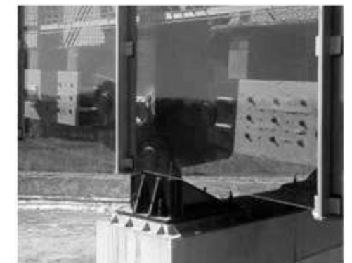
Nodo en marco de concreto del mirador. Derecha vista de nodo con cancelería instalada.
