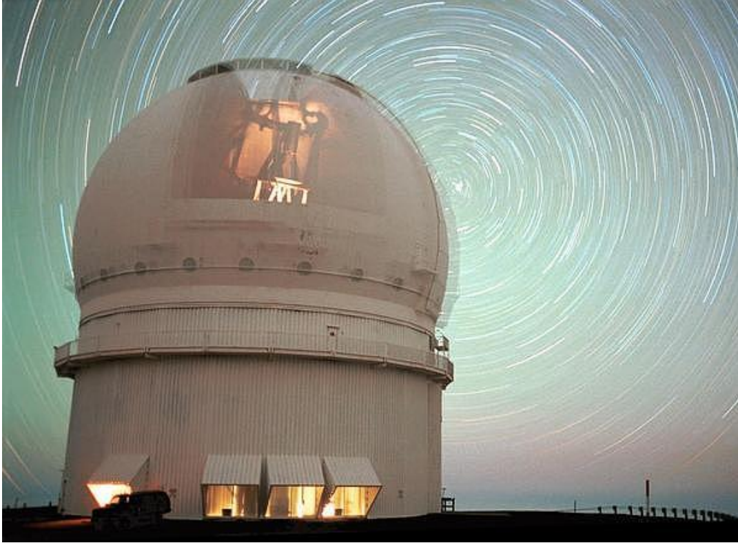
Figura 2.5: Observatorio Canada-Francia-Hawaii (CFHT) ubicado en la cima del Mauna Kea en la isla de Hawaii. Cuenta con un espejo primario de 3.58 metros de diámetro.
