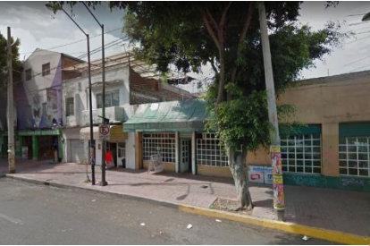
Foto 3. La calle cuenta con varios comercios en planta baja y algunas viviendas en primer nivel.
