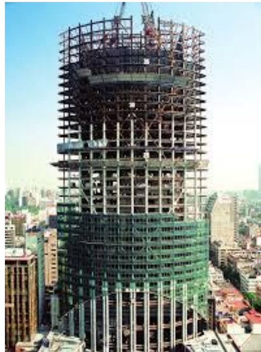
Imagen 20. Estructura Edificio Torre Mayor, CDMX. (*) (Fotografía)
