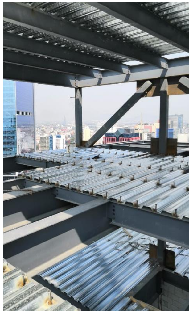
Imagen 44. Sistema Losacero “Centro Insurgentes Reforma” 2019 Fotografías Claudia Aguilar
