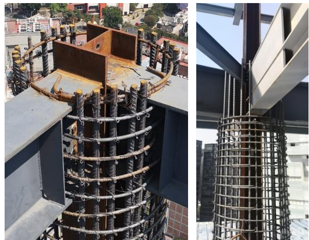
Imagen 43. Columna mixta "Centro Insurgentes Reforma" 2019 Fotografías por Agustín Sánchez
