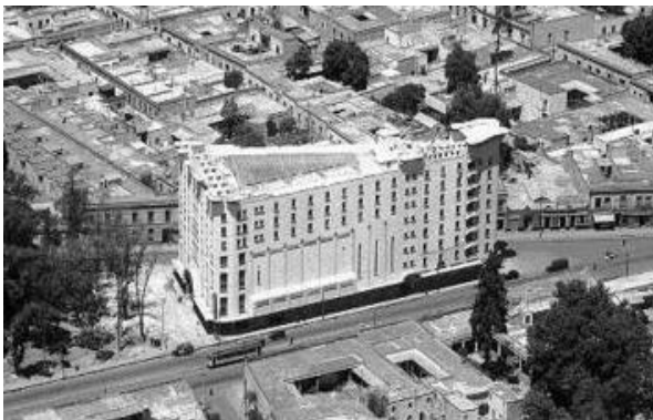
Imagen 11. Vista aérea Edificio Ermita (Fotografía) Fuente: Fundacionmierypesado.org.mx, 2018.
