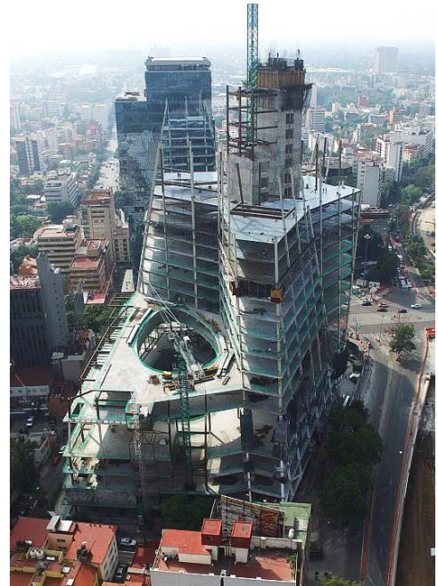
Imagen 22. Proceso de construcción Estructura - Torre Manacar..(*) (Fotografía)
