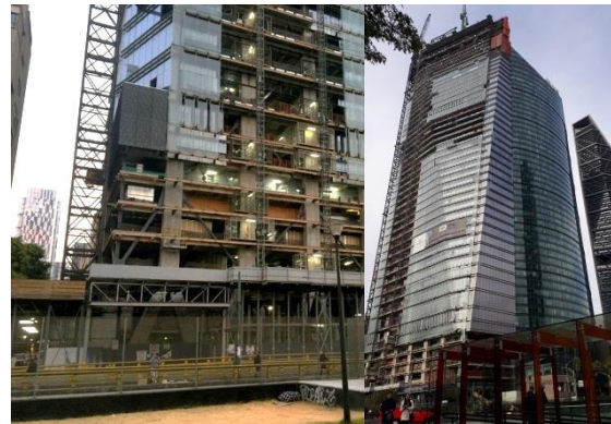
Imagen 15. Estructura Chapultepec Uno (*) (Fotografía)
