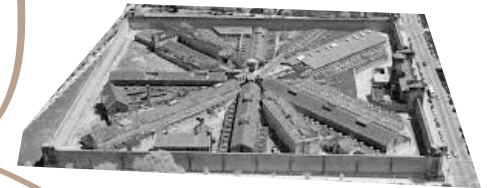
Palacio de Lecumberri. Vista aérea. Notar la planta de tipo panóptico.
