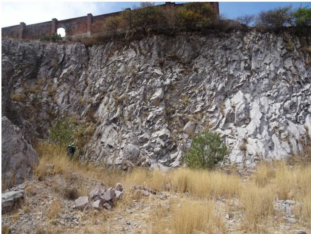
Figura 38. Zona 1 con muralla en la berma superior del talud.
