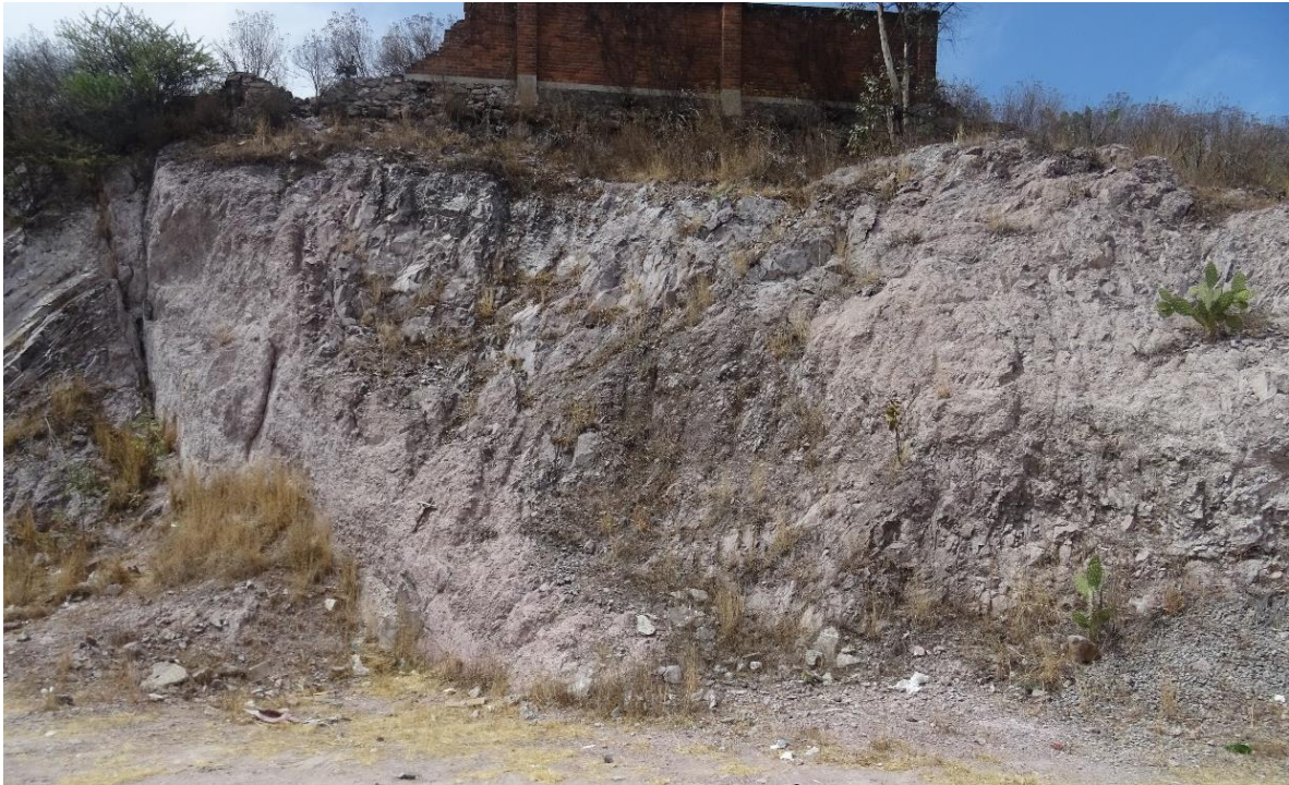
Figura 44. Muralla sobre ZG3.
