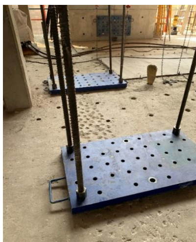
(b) Anclaje de placas de apoyo.
