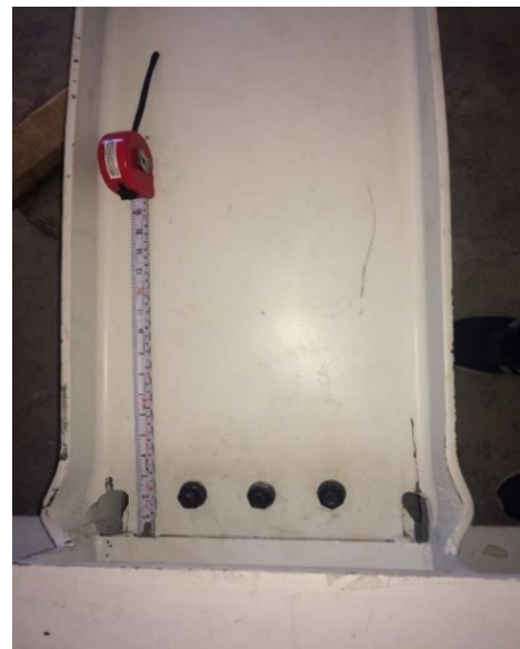
(b) Acercamiento a la articulación en la trabe
