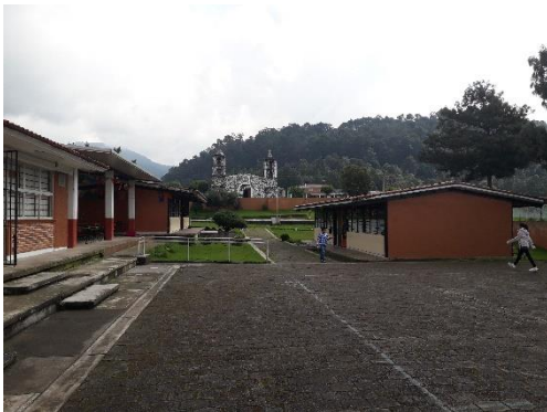
Foto 2 Escuela Francisco I Madero
