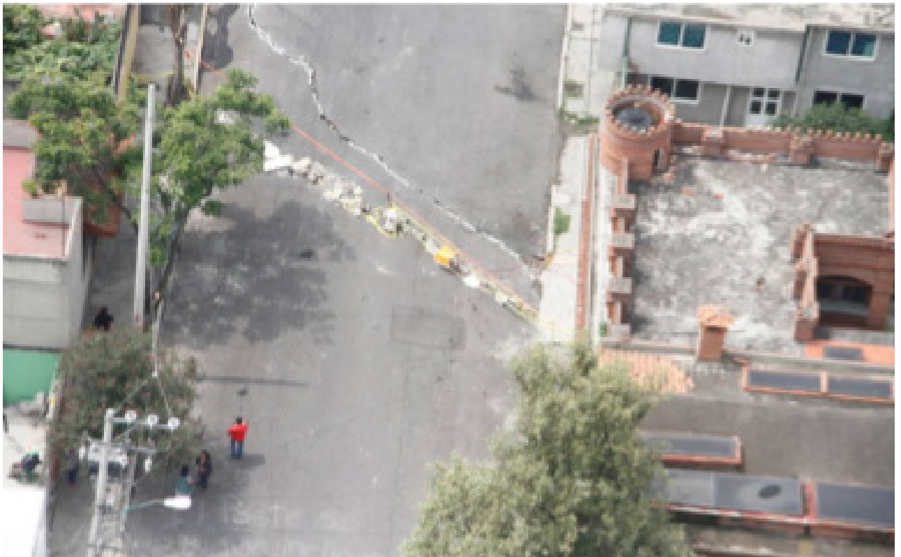
Arriba. Figura 5.13 Fotografía de grietas en Tláhuac.
