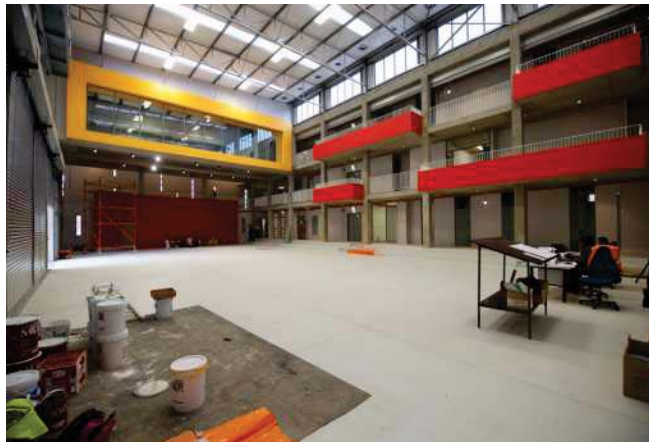
IMAGEN 31.- Área de ensayo y calentamiento
