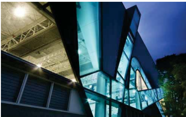
IMAGEN 25.- Detalles de fachada principal
