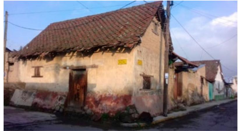
**Img. 25.** Vivienda vernácula Amecameca, con techos de teja madera como elemento estructural, piedra y adobe en muros
