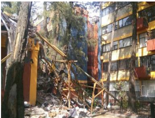
Imagen. 57 edificios colapsados posterior al sismo
