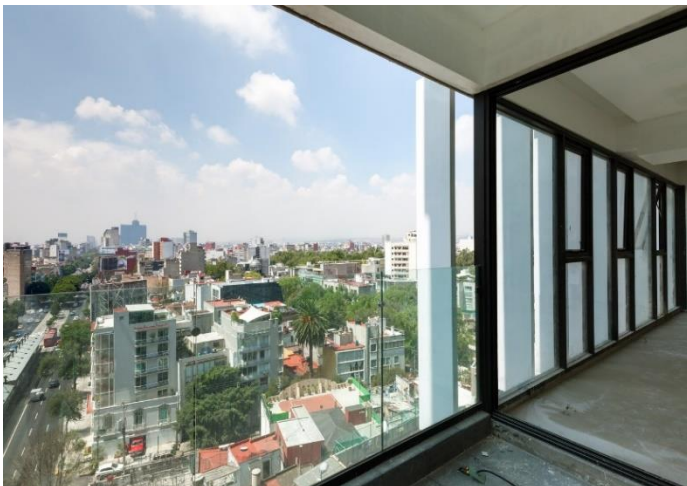
Imagen. 15 vista de fachada del edificio. Archidaily.com
