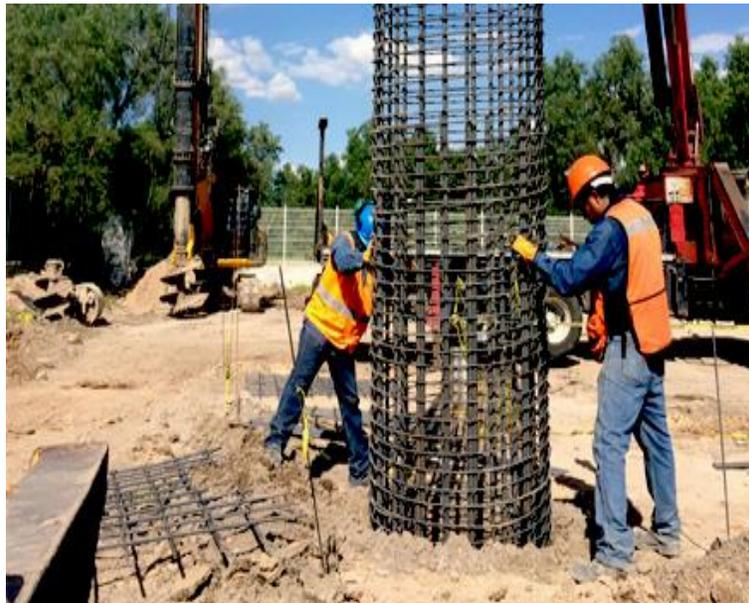
*Fig. 34 " Pila de cimentación (Derco, 2016) "*
