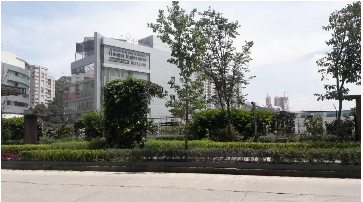
Figura 41. Fotografía del lado suroeste (vista hacia la calle Mario Pani) del predio. Elaboración propia.
