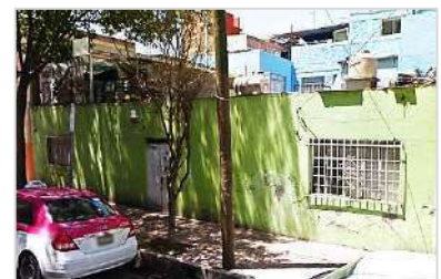
Figura 17. Vivienda de 1 nivel, Calle Lago Mayor. Fuente: Google Maps 2019
