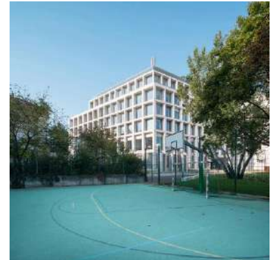
Figura 84. Cancha, edificio Post Viena. Foto: Lukas Schaller Fuente: www.archdaily.mx
