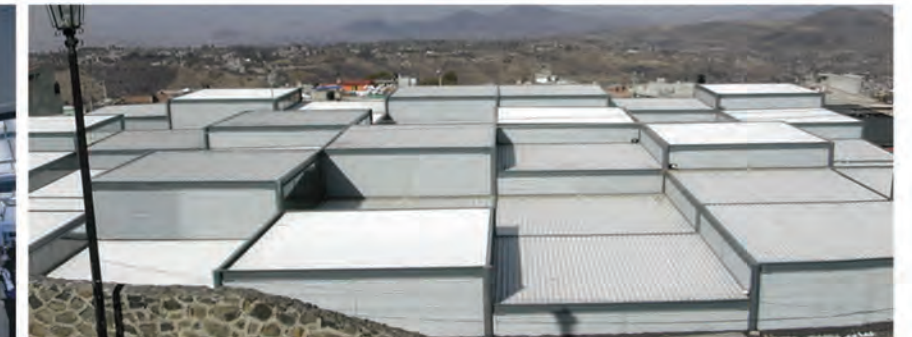
Figura 5: Exterior Mercado (Luis Gordo, RedFundamentos, 2019)
