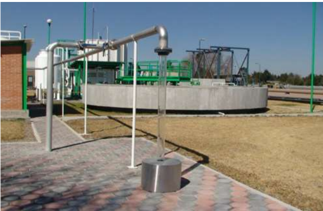
Foto 7. Inyección del agua para recarga Artificial.
