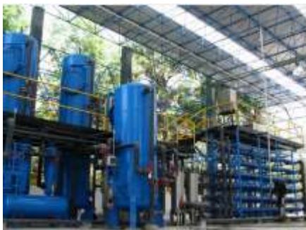
Foto 2. Área post tratamiento
