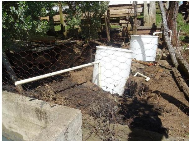
Figura 3.25 Segundo y tercer filtro instalados (Elaboración propia, 2019)
