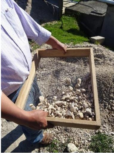
Figura 3.22 Grava cribada para segunda capa (Elaboración propia, 2019)
