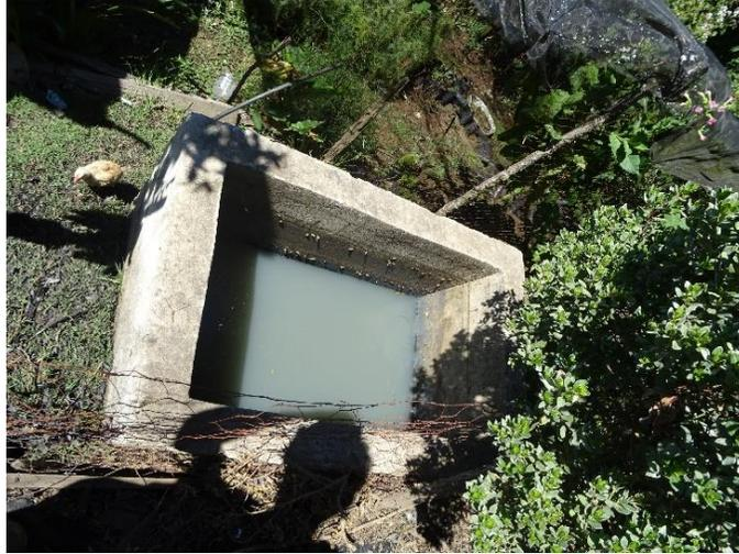
Figura 3.5 Tanque de almacenamiento para reuso de las aguas grises, Joltojtik, municipio de Chamula (Elaboración propia, 2019)
