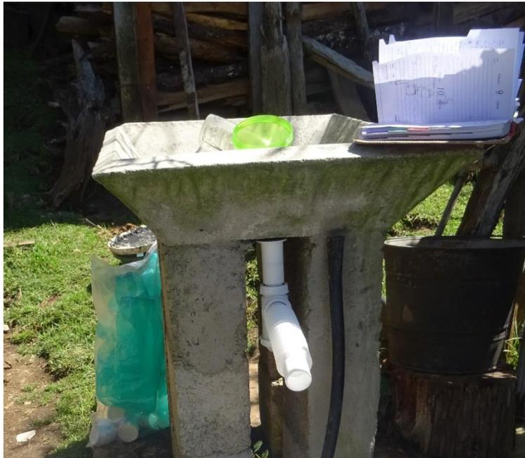
Figura 3.27 Sistema de tubo para fregadero y céspol en batea exterior de vivienda beneficiada (Elaboración propia, 2019)
