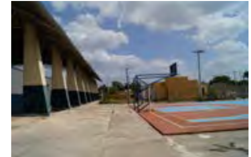
▲ Fotografía 41. Deportivo sin mantenimiento. Fotografía propia.
