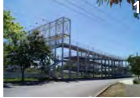
▲ Fotografía 28. Puente peatonal. Fotografía propia.
