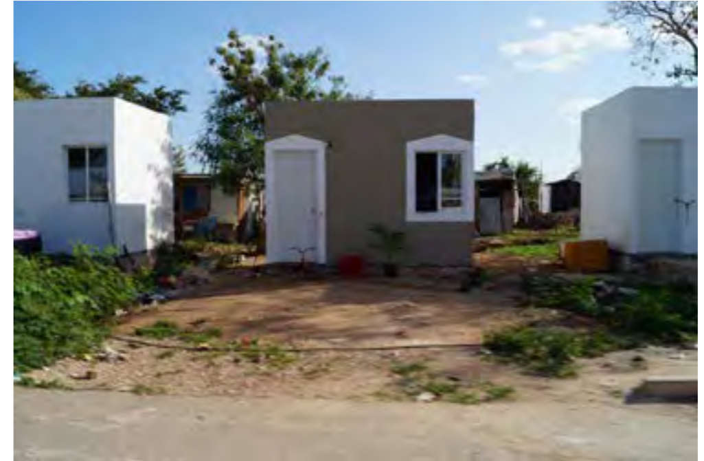
▲ Fotografía 26. Cuarto en zona de paracaidistas "El Paredón". Fotografía propia.
