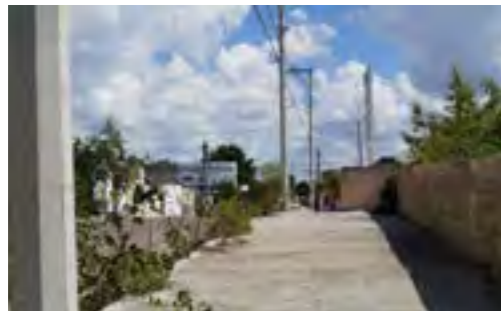
▲ Fotografía 36. Banqueta excesiva sin vegetación. Fotografía propia.
