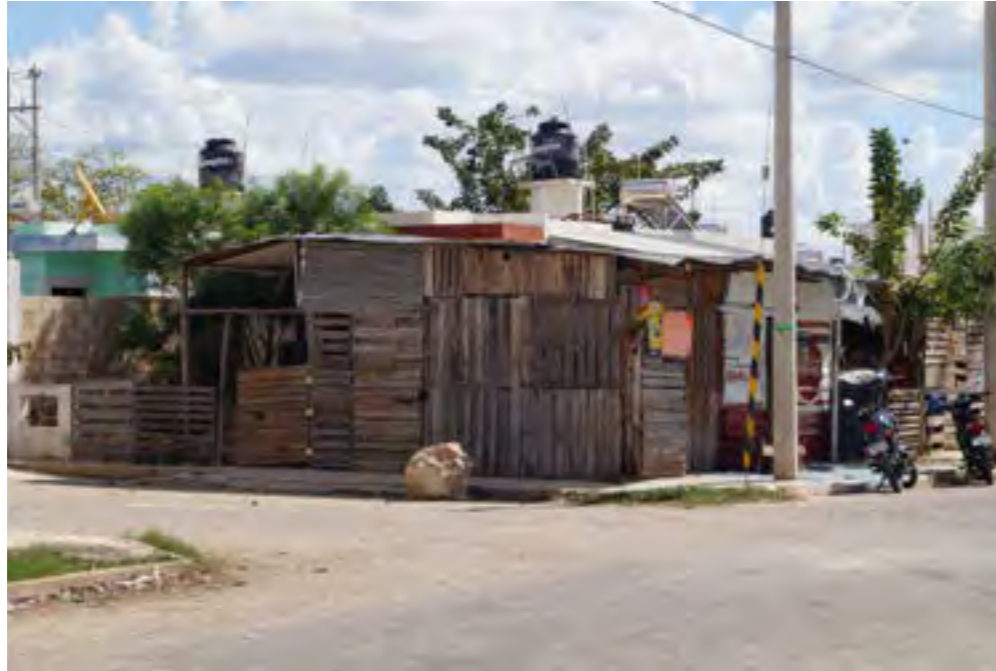
▲ Fotografía 25. Casa hecha a partir de tablas de madera y lámina galvanizada. Fotografía propia.
