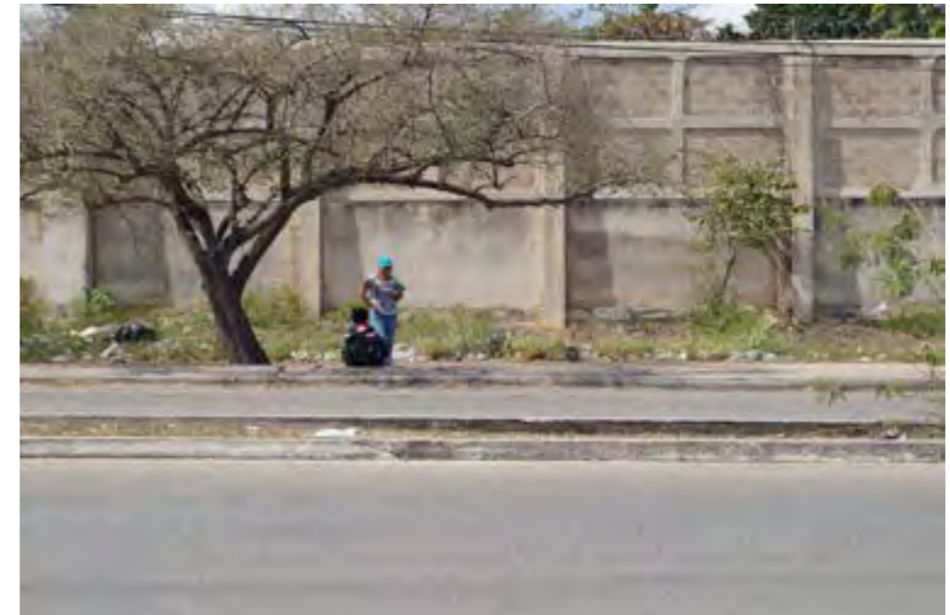
▲ Fotografía 13. Muro sur del aeropuerto. Fotografía propia.
