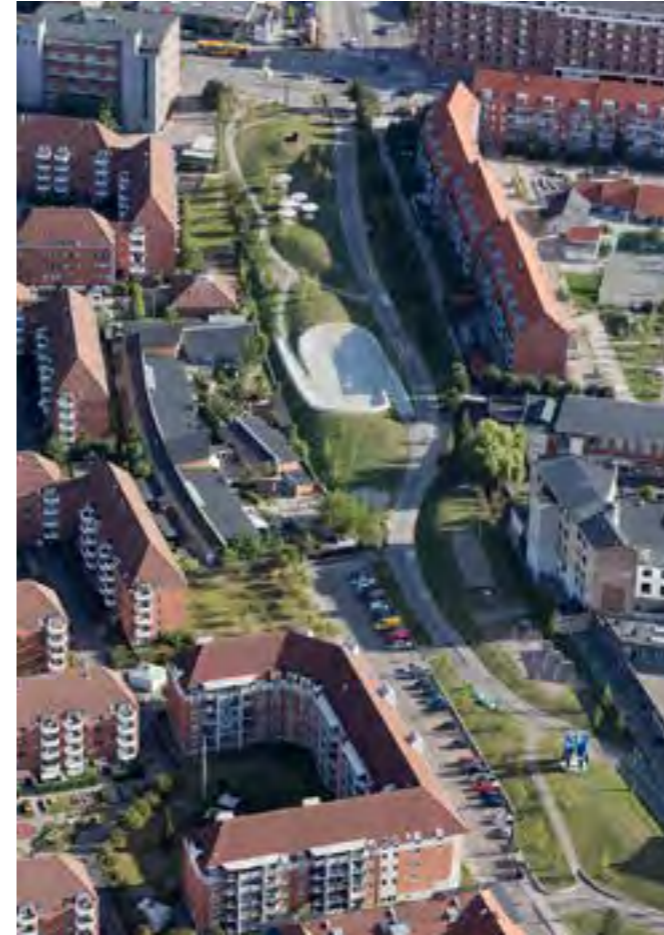
▲ Fotografía 51. The Green Park. Por Iwan Baan. 2012.
