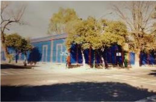
**Muros:** Mixto de adobe, tepetate, tepojal y tabique rojo de 45cm de Espesor.
