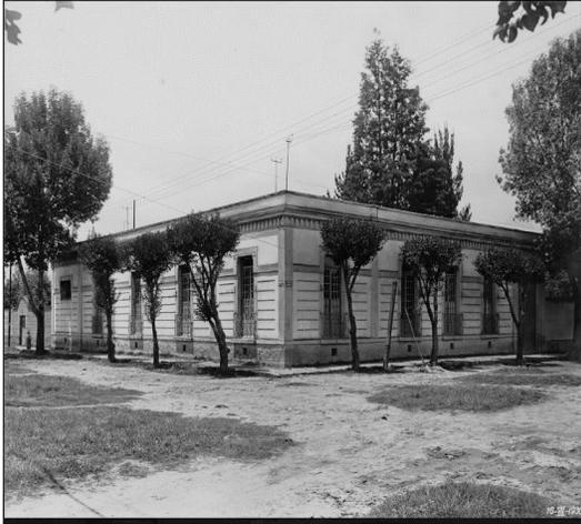
**Muros:** Mixto de adobe, tepetate, tepojal y tabique rojo de 45cm de Espesor.
