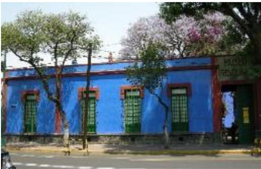
**Muros:** Mixto de adobe, tepetate, tepojal y tabique rojo de 45cm de Espesor.
