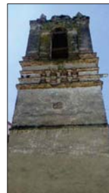
Foto 3. Torre exenta, cara Norte. El desgaste de los aplastados muestra las fabricas de la torre.
