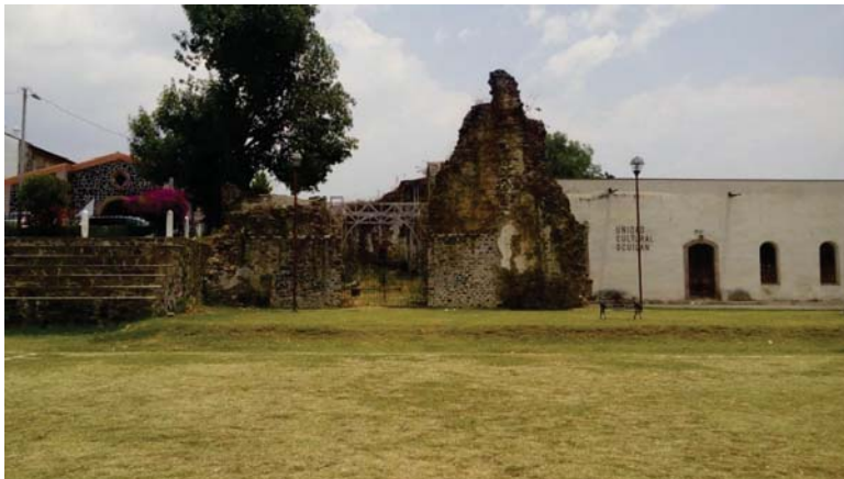
Fig. 1.8 Antiguo templo y convento agustino de Ocuilan, desplantado sobre la plataforma piramidal que se puede ver cubierta de pasto; La piedra con la que se construyó el templo fue tomada de esta plataforma. (Fotografía INCHS)
