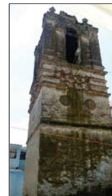
Foto 4. Torre exenta, cara Poniente. Nótese las 3 piedras incrustadas con motivos religiosos.
