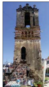
Foto 2. Torre exenta cara sur. Las escaleras fueron hechas en 1986, el acceso estaba en altura por motivos de seguridad ya que evitaba que cualquiera pudiera acceder a las campanas.
