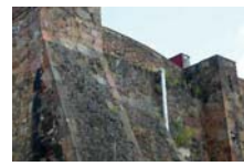
Foto 3 (LNGRS, 19-Oct-2017) La suciedad en los techos del templo provoca el crecimiento de flora y líquenes de todo tipo.
