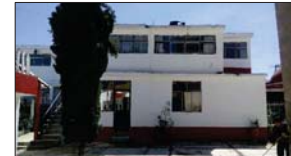
Foto 6. Vista hacia la casa Parroquia. En la esquina inferior izquierda se muestra una pendiente que baja a todo lo largo del área de oficinas y se puede apreciar en la foto 5 en el plano Ar-01 se muestra la coincidencia de esta con el trazo de la plataforma pre-supuesta en este trabajo.
