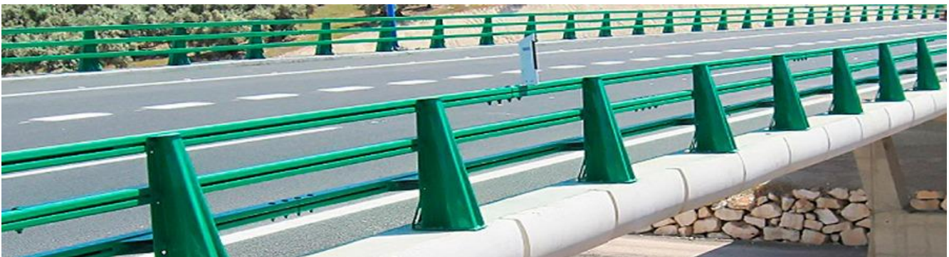
Figura 45. Parapeto de un puente
