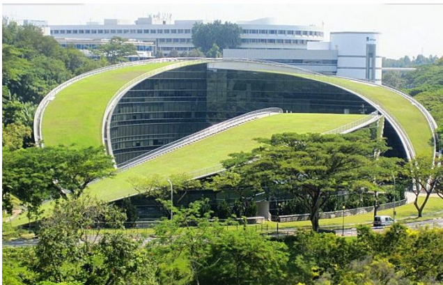
Aplicación de cubierta ajardinada para azotea
