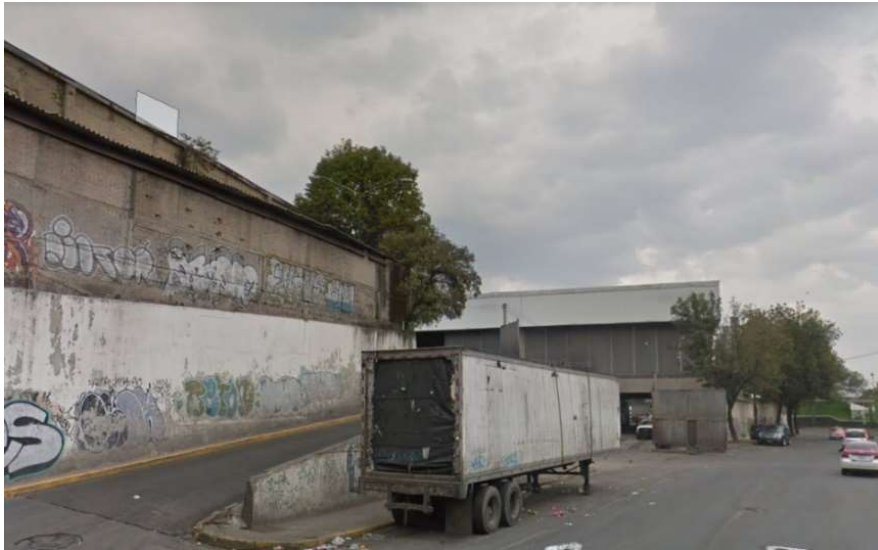
Imagen 26. Acceso a planta de transferencia [fotografía]. Fotografía propia
