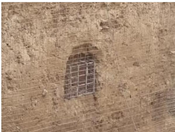
Figura 4.4: Pared de la excavación perfilada, con armado de zapata de reacción de las anclas y con malla de refuerzo.
