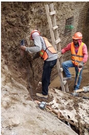
Figura 4.2: Perfilado del terreno.
