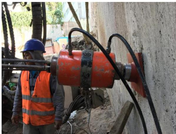
Figura 4.12: Gato hidráulico con capacidad de 300 ton utilizado para el tensado de los torones.
