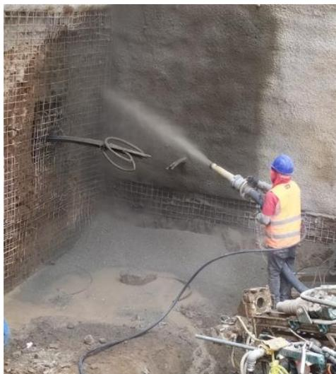
Figura 4.10: Lanzado de concreto vía seca.
