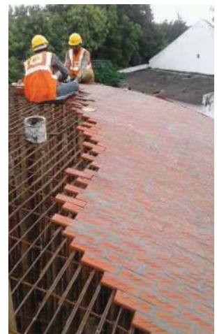
Vista de sistema [Fotografías]. Fuente: ArchDaily (2019).
