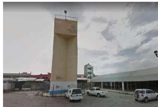
Tanque elevado ubicado en el mercado municipal [Fotografía]. Fuente: Propia
