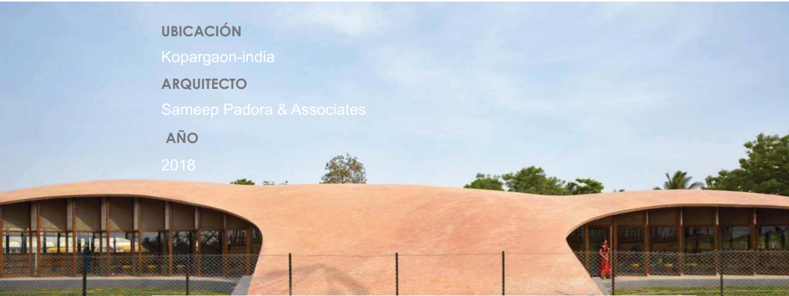
Vista exterior de cubierta [Fotografía]. Fuente: ArchDaily (2019).
