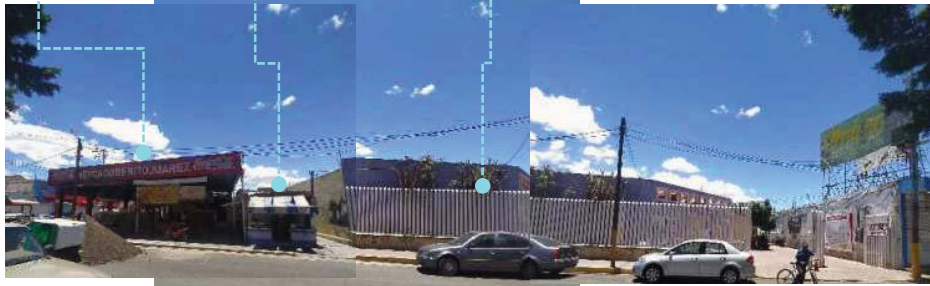
Panorámica fachada sur [Fotografía]. Fuente: Propia
