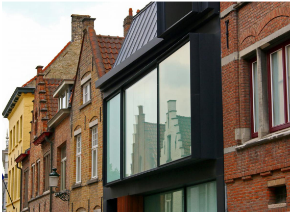
Ilustración 15.- Brujas, Bélgica. Intervención en viviendas históricas.
