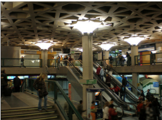
Ilustración 10.- Plafones con uso de fibra de vidrio, España. “Características físicas y mecánicas de hormigones reforzados con fibras de: vidrio, carbono y aramida”
