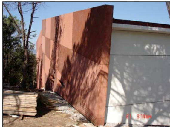
Ilustración 11.- Uso de concretos con fibra de vidrio en fachadas, España. “Características físicas y mecánicas de hormigones reforzados con fibras de: vidrio, carbono y aramida”
