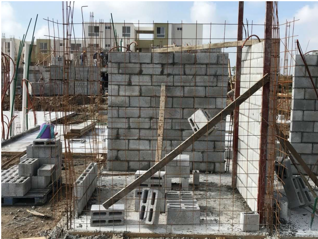
Plomo de muro interiormente reforzados.
