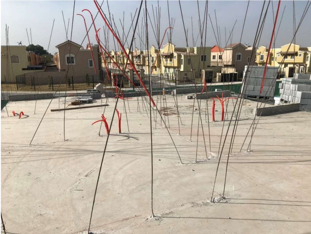
Habilitado de refuerzo vertical en losa de cimentación para mampostería interiormente reforzada.
