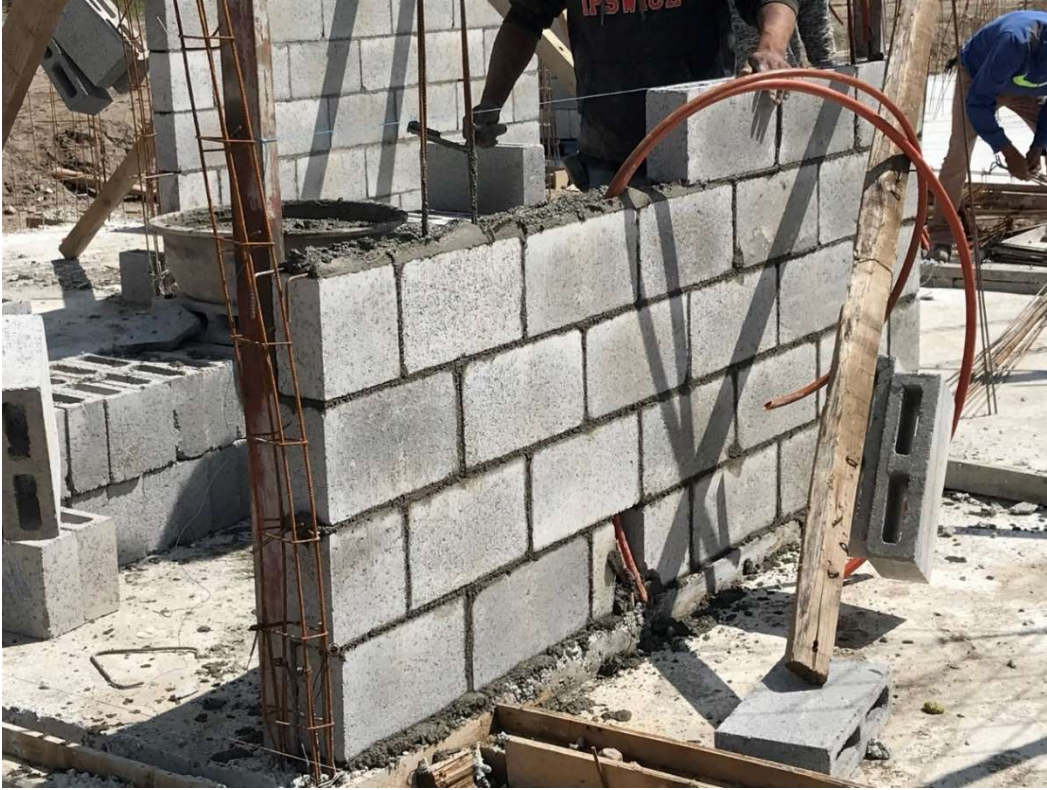
Instalaciones embebidas en los block.
