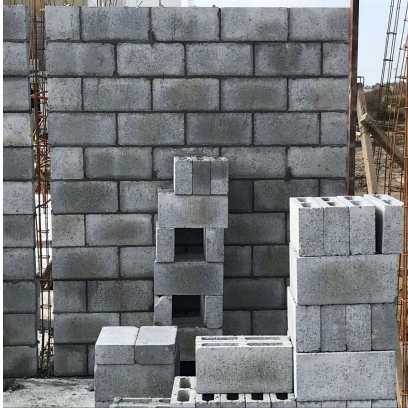
Muro concluido, detenido con bloques para prevención de desviación vertical.
