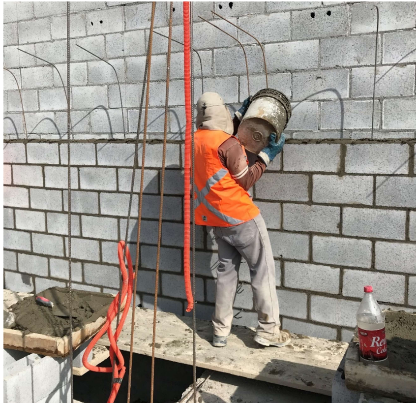
Colado de celdas con refuerzo vertical, en mampostería interiormente reforzadas
