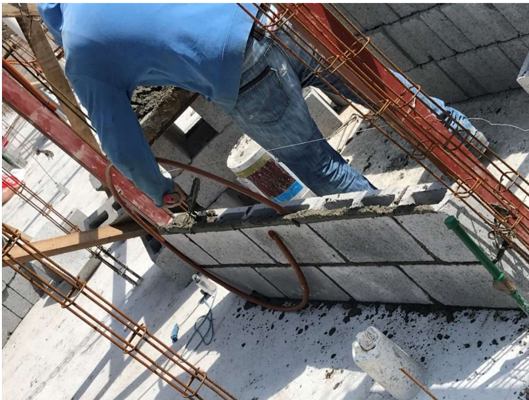
Proceso constructivo, alineado con hilo, junteo con mortero y colocación de block.
