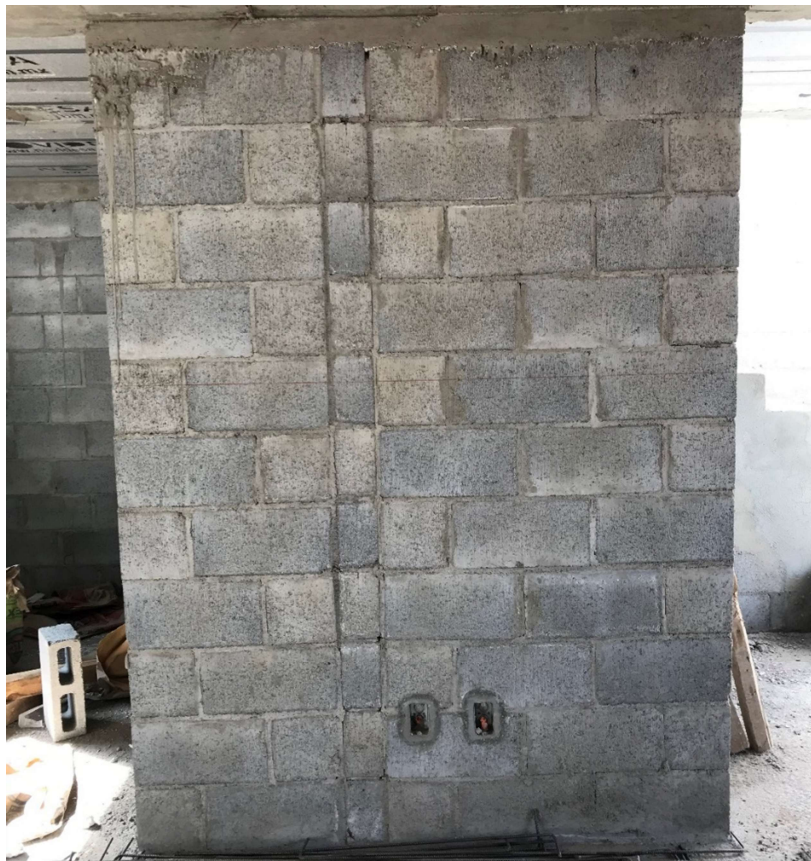
Traslapes o esquinas de muros interiormente reforzados.
