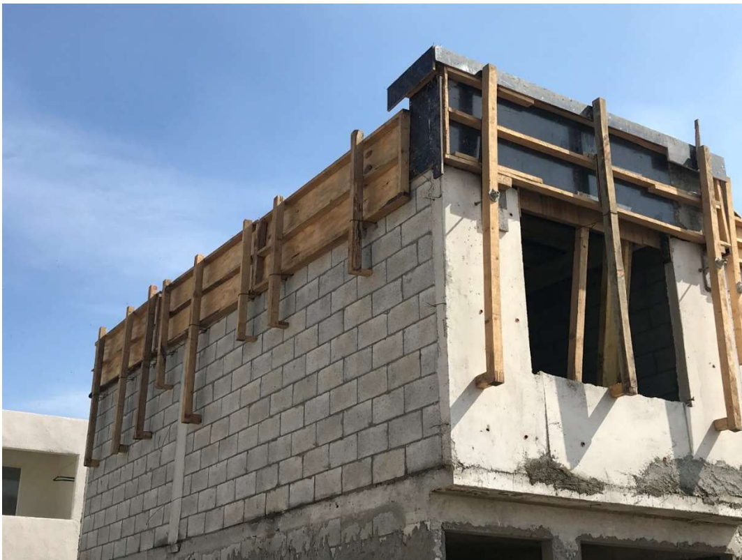
Cimbrado de dalas de cerramiento en mampostería confinada.
