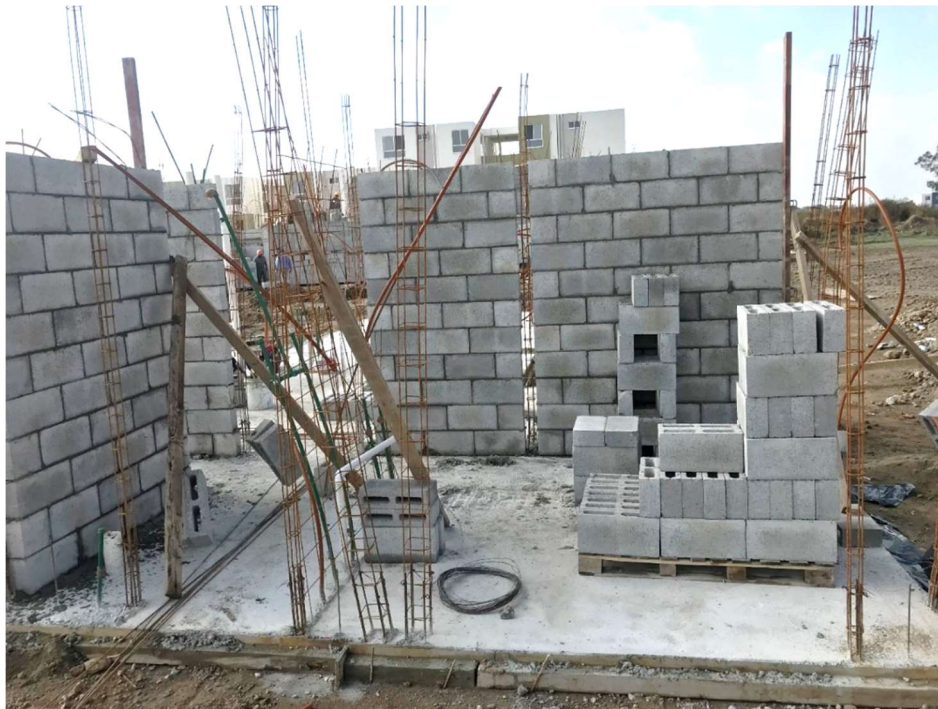
Área de trabajo, materiales, avance de muro, castillos pendientes de colar.
