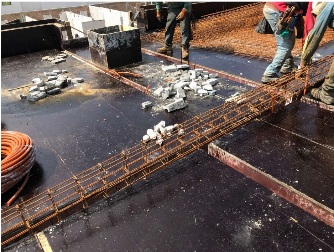
Habilitado de acero para losa de entrepiso.
