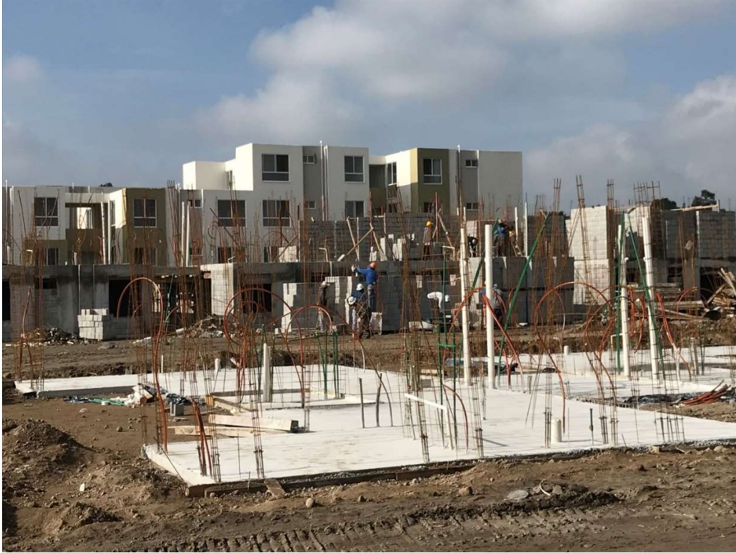
Losa de cimentación con armado de castillos embebidos en ella.
