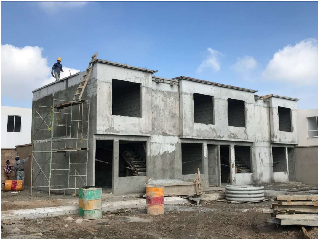
Mampostería Interiormente Reforzada (terminada).
