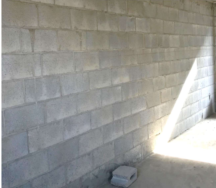
Muro interiormente reforzado (terminado).
