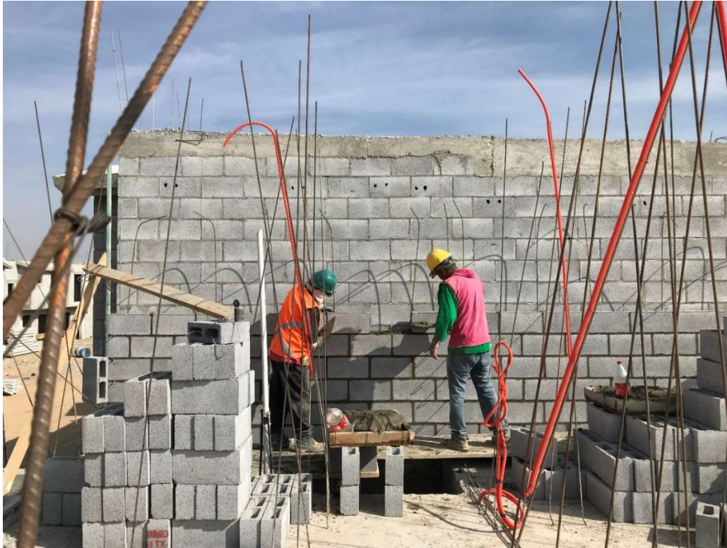
Mano de obra en acción (Mampostería interiormente reforzada).
