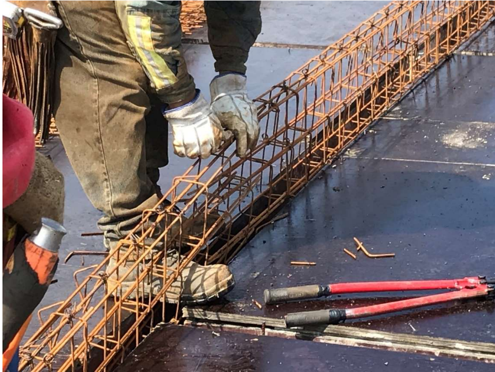
Habilitado de acero para losa de entrepiso
