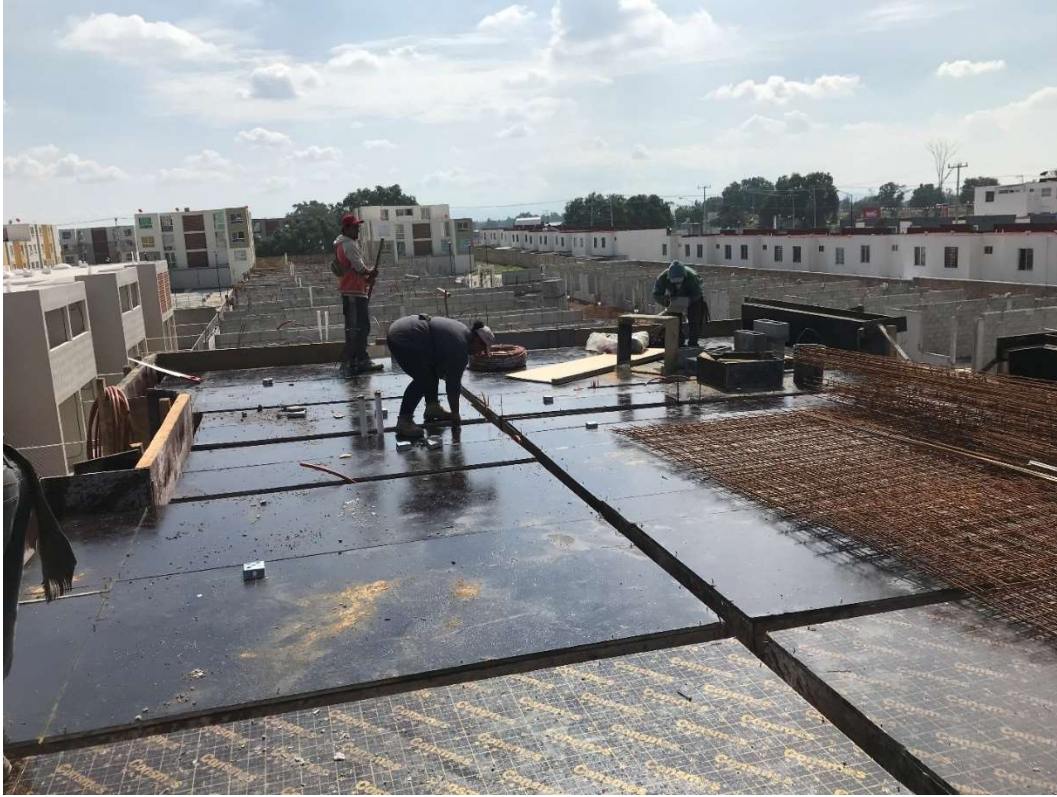
Cimbra y habilitado de acero para losa de entrepiso
