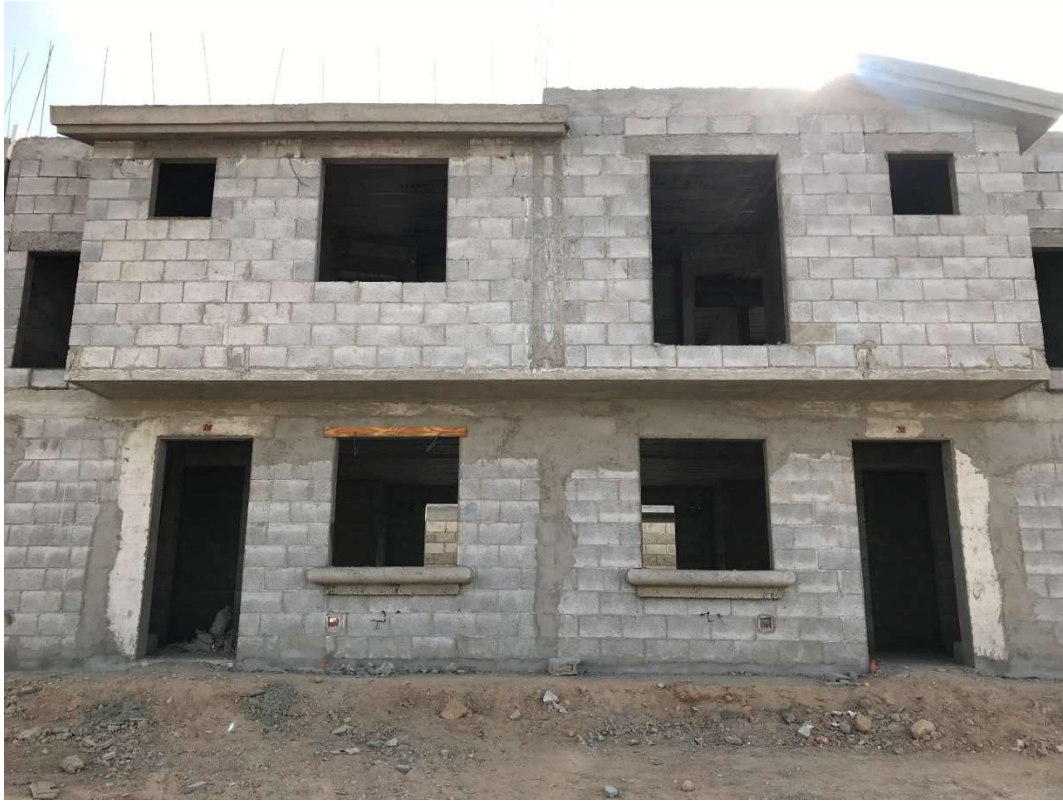
Fachada principal de casas con muros interiormente reforzados.
