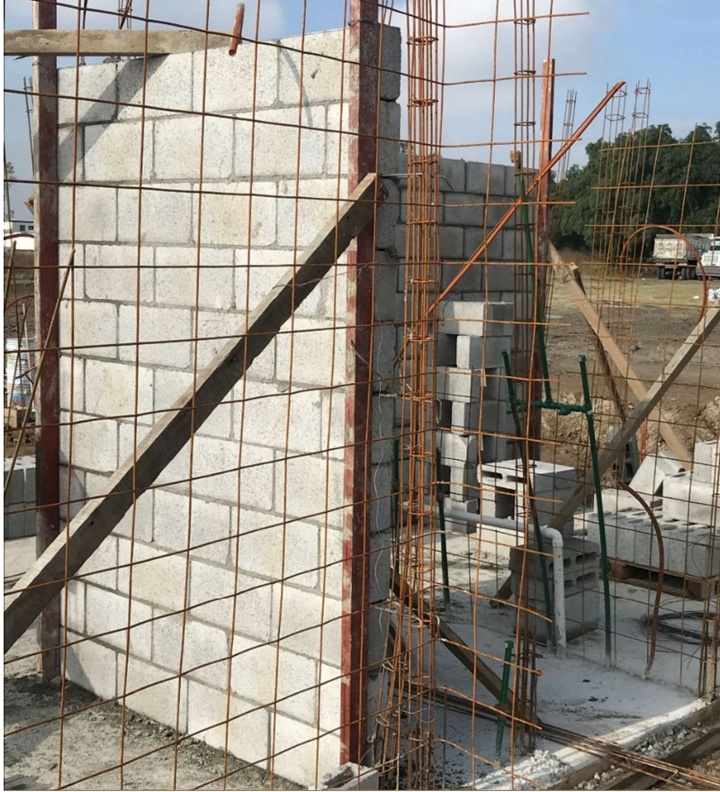
Muro concluido, siguiente paso colado de castillos.
