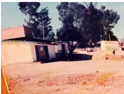
Figura 22 Construcción edificio secundario y módulos sanitarios.
