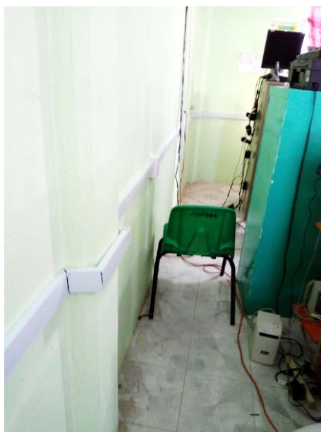
Figura 69 Instalación de canaleta área administrativa.
