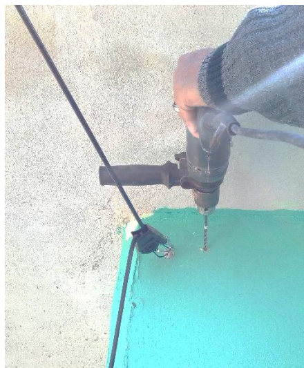
Figura 81 Colocación del tensor a la armella.
