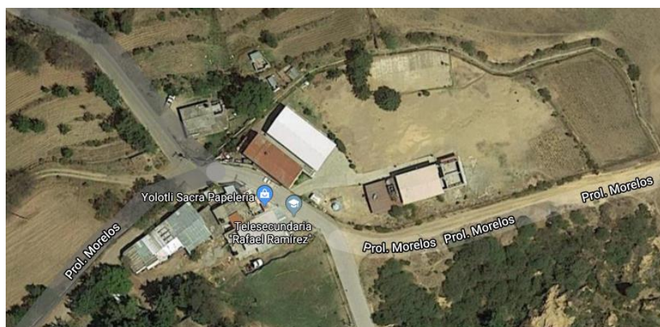
Figura 19. Vista área Telesecundaria Rafael Ramírez, fuente: Google Maps 2020
