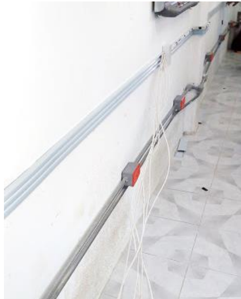
Figura 44 Tendido de cable UTP.
