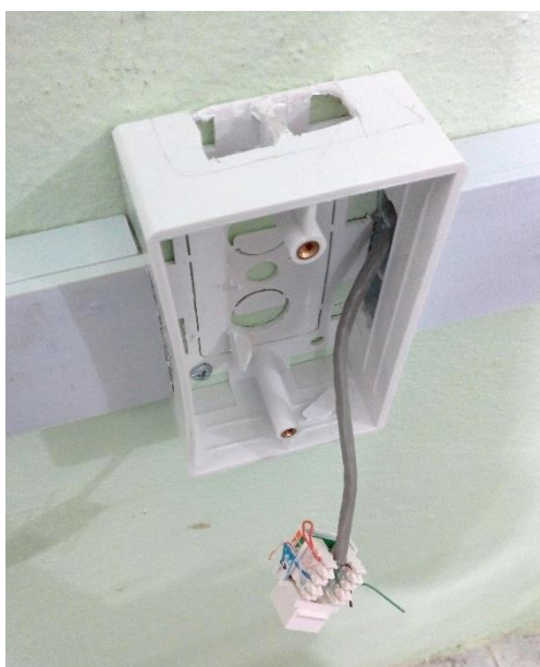
Figura 70 Ponchado de cable en Jack.
