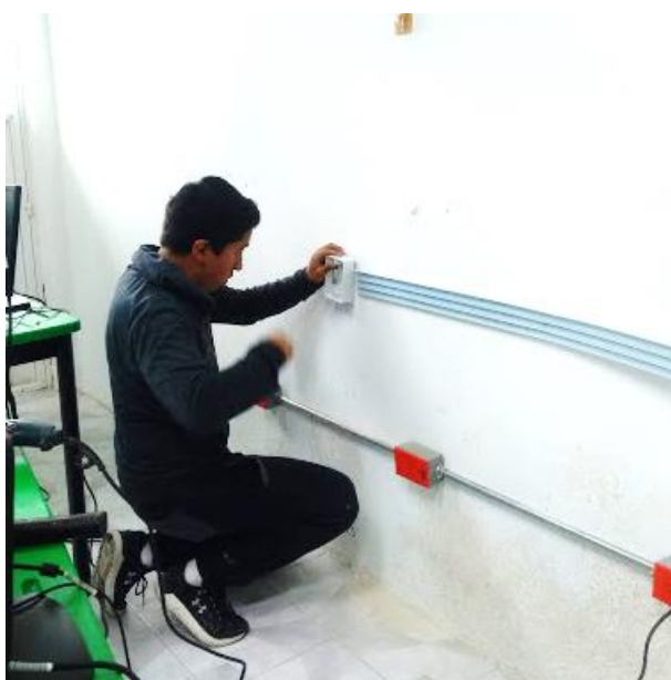
Figura 40. Instalación de Canaleta.
