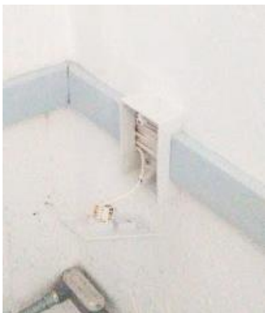
Figura 49. Fijación de Jack RJ45 a tapa de red.
