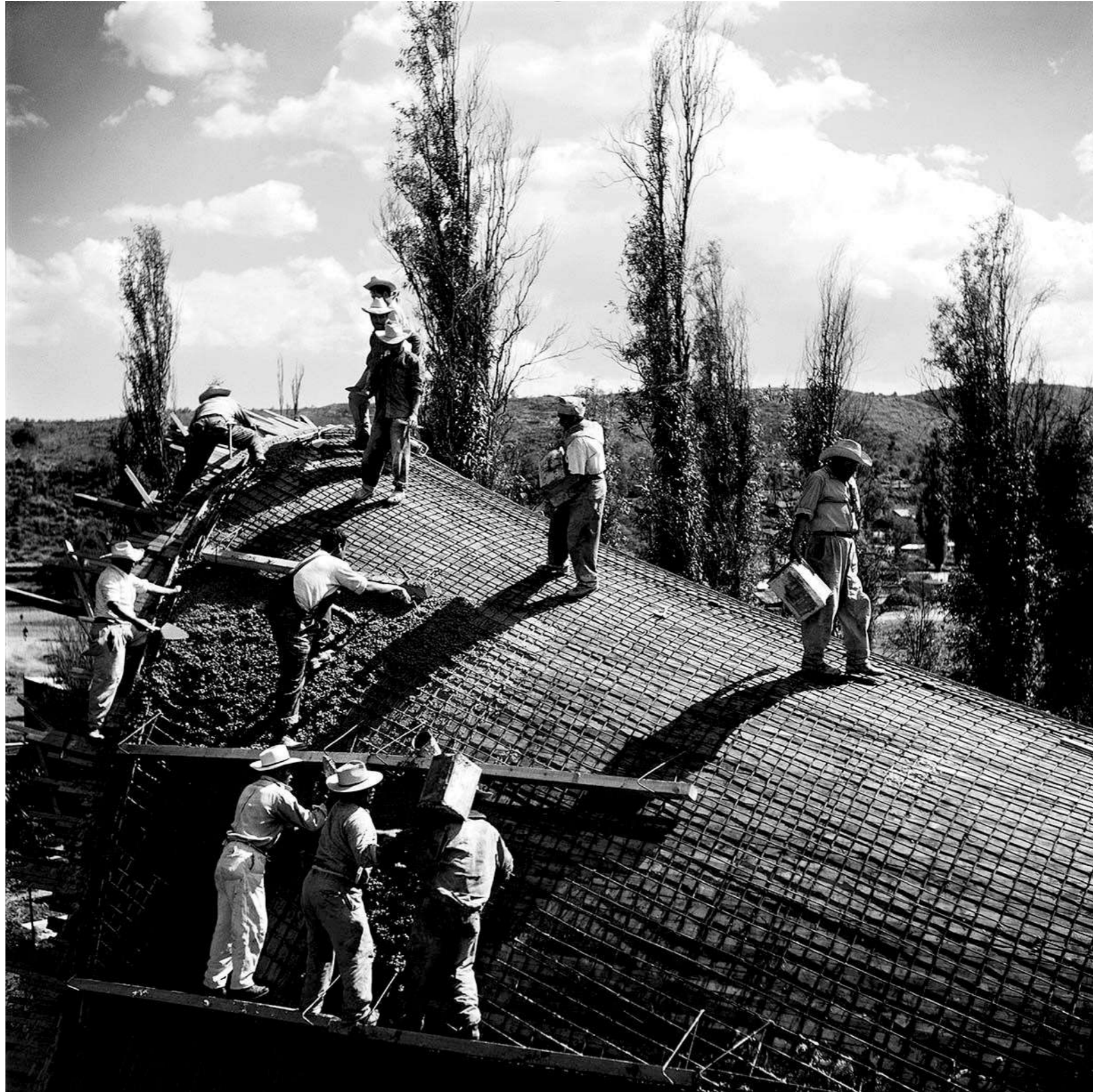
22. Fotografía del encofrado y proceso de colado para la cubierta del restaurante Los Manantiales (1958), basado en el sistema de bóveda por arista. 3 Proyecto: Joaquín Álvarez Ordoñez. Construcción: Félix Candela. Fuente: Princeton University Archive. Fondo fotográfico: Félix & Dorothy Candela.
