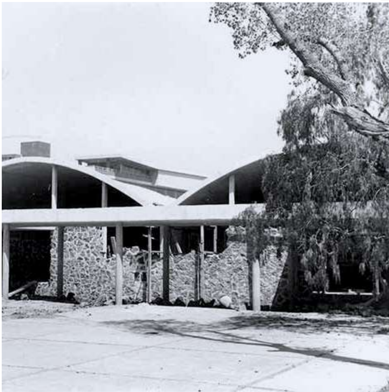
103. Fotografía de las obras en el Auditorio de la Facultad de Química UNAM (noviembre 1953). Fuente: AHUNAM IISUE. Fondo fotográfico: Saúl Molina Barbosa / Carlos Lazo Barreiro.
