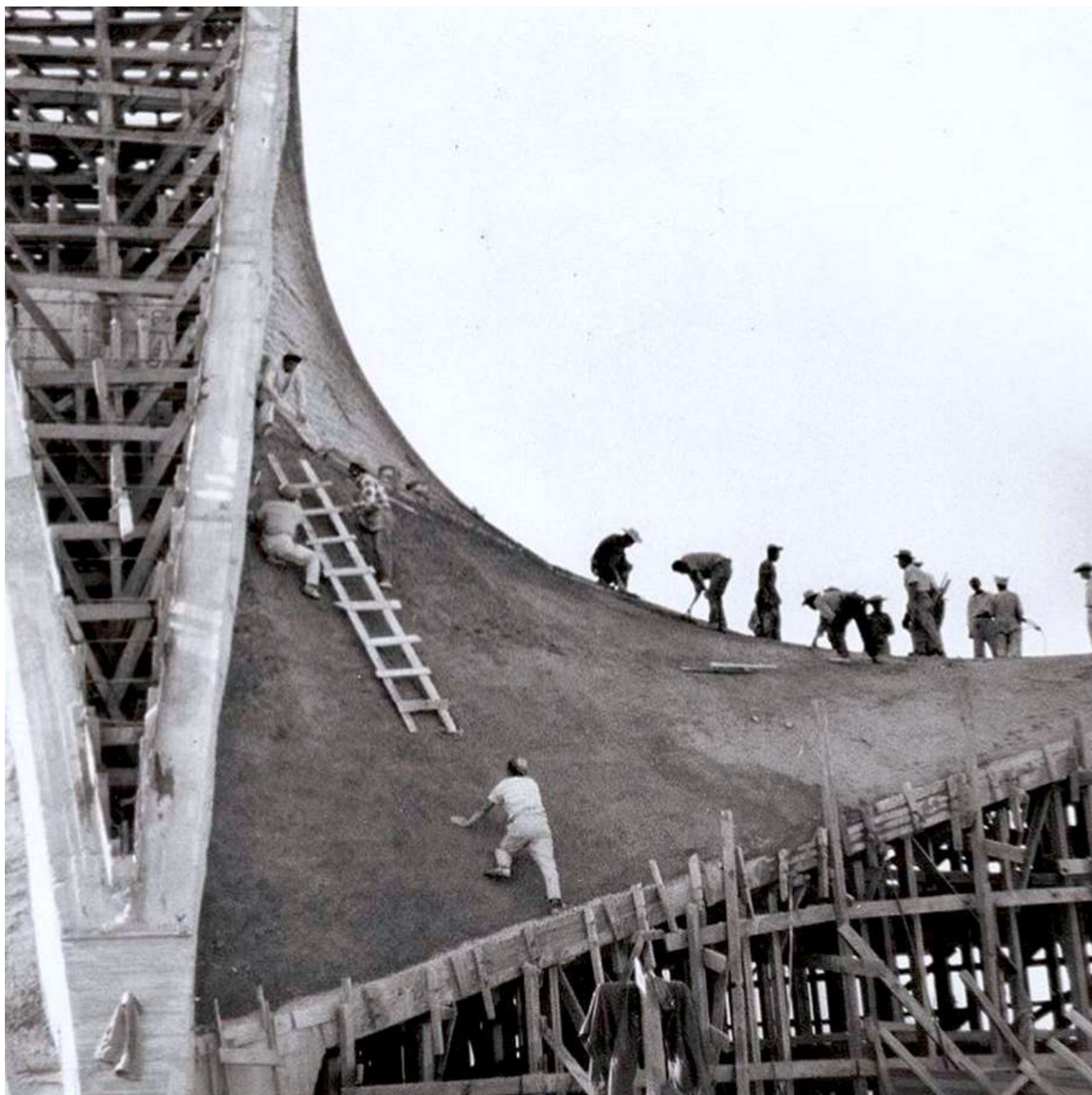
23. Fotografía que documentó los trabajos en cubierta, para las obras en la Iglesia de San José Obrero. Monterrey (1959). Fuente: Princeton University Archive. Fondo fotográfico: Félix & Dorothy Candela.
