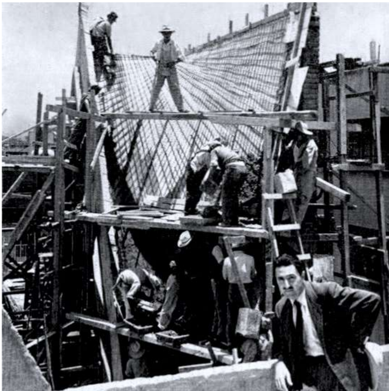
06. Fotografía de Félix Candela supervisando las obras durante el proceso de encofrado en la Iglesia de la Medalla Milagrosa. Colonia Narvarte, Ciudad de México (1955). Fuente: Princeton University Archive. Fondo fotográfico: Félix & Dorothy Candela.
