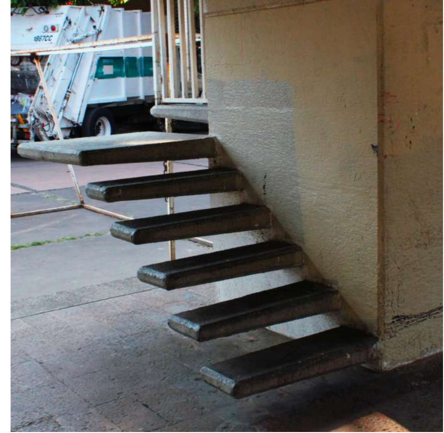
Acercamiento a las escaleras de acceso al edificio. Estas escaleras no corresponden a las originales, las cuales fueron demolidas y modificadas a finales de la década de 1970.
