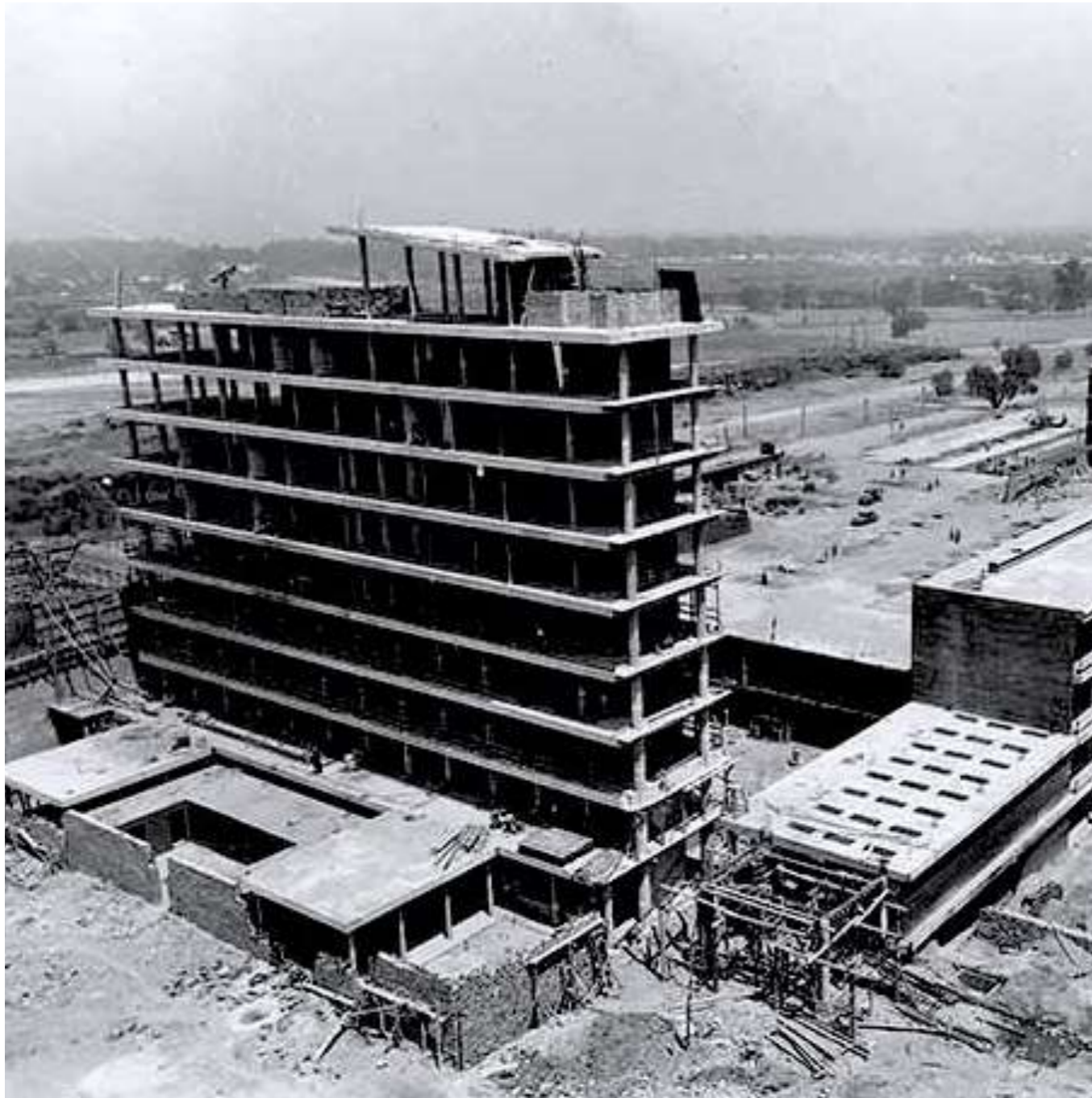
69. Fotografía de los procesos de obra en la Torre I de humanidades (marzo 1952). Fuente: AHUNAM IISUE. Fondo fotográfico: Saúl Molina Barbosa / Carlos Lazo Barreiro.
