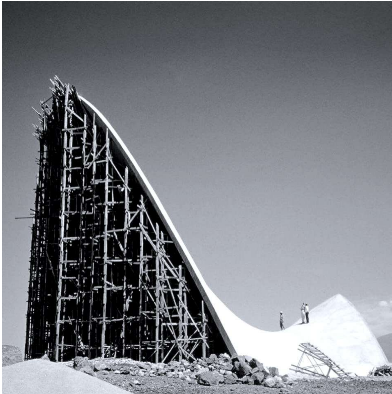
21. Fotografía de las obras en la Capilla abierta de Palmira en Cuernavaca, México (1958). Fotografía recuperada de la exposición: "Félix Candela's Concrete Shells: An Engineered Architecture for Mexico and Chicago. Fuente de origen: Princeton University Archive. Fondo fotográfico: Félix & Dorothy Candela.
