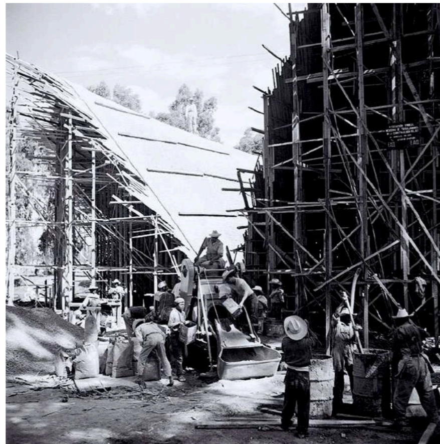
Encofrado en cimbra para la construcción de las bóvedas por arista que conforman la cubierta del restaurante Los Manantiales.
