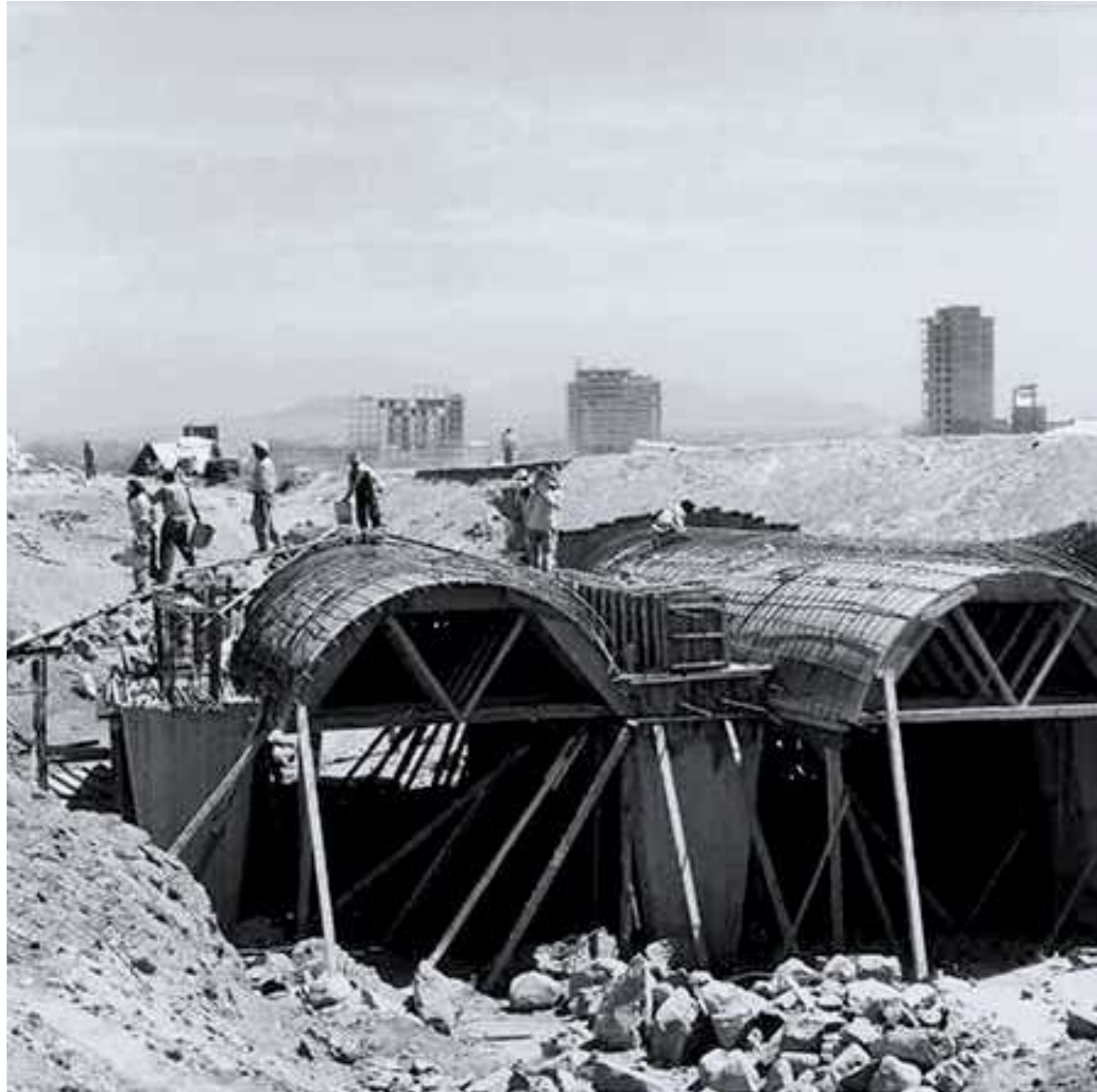
75. Fotografía de las obras del viaducto para peatones ubicado en Circuito Escolar, frente al acceso norte del Estadio Olímpico Universitario. Se observa a los trabajadores haciendo maniobras encima del encofrado utilizado para geometrizar los túneles basados en arcos de medio punto. Al fondo, se visualizan las obras de la Torre Rectoría, la Biblioteca Central y la Torre I de Humanidades (marzo 1952). Fuente: AHUNAM IISUE. Fondo fotográfico: Saúl Molina Barbosa / Carlos Lazo Barreiro.
