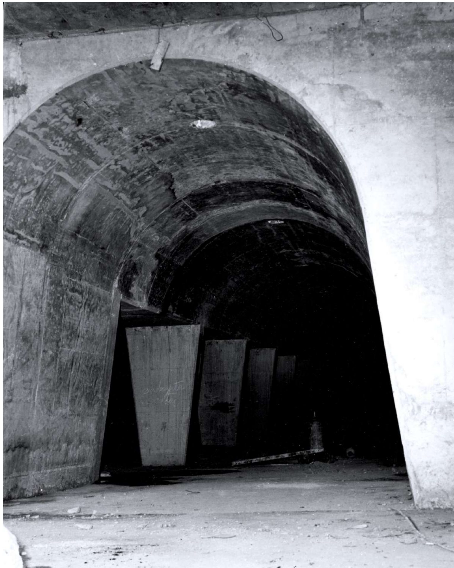
52. Fotografía de las obras del Túnel maratón en el Estadio Olímpico Universitario, obra del Arquitecto Félix Candela (1952). Fuente: AAM/FA/UNAM. F: APP.
