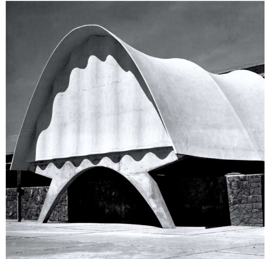
Fotografía de las obras concluidas del Laboratorio de Rayos Cósmicos, a finales de noviembre de 1952, previo a celebrarse los eventos en torno al día de la dedicatoria de Ciudad Universitaria.
