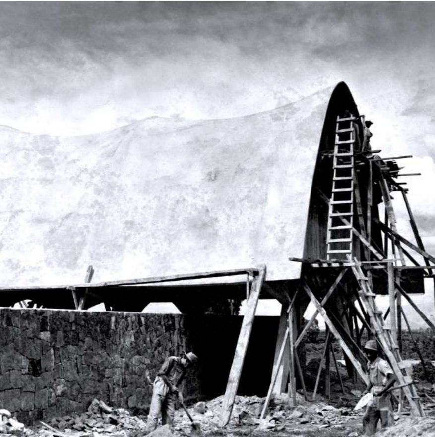
Se desmonta el encofrado de madera y se trabajan en los acabados finos de la cubierta y el interior del laboratorio.
