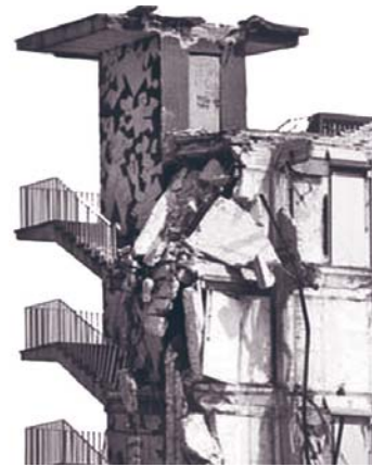
Figura 2.9 Restos del multifamiliar Juárez después del sismo de 1985. Fuente: Milenio. (imagen obtenida de: https://bit.ly/2QuGcFY )
