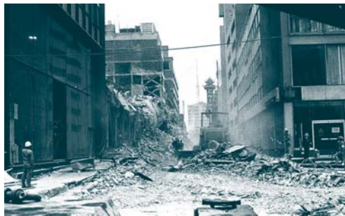
Figura 2.6 Fotografía donde se aprecian los trabajos post sísmicos en la calle de Iturbide. Fuente: Archivo de El Universal. Colección Villasana-Torres (imagen obtenida de: https://bit.ly/2xLswQs )
