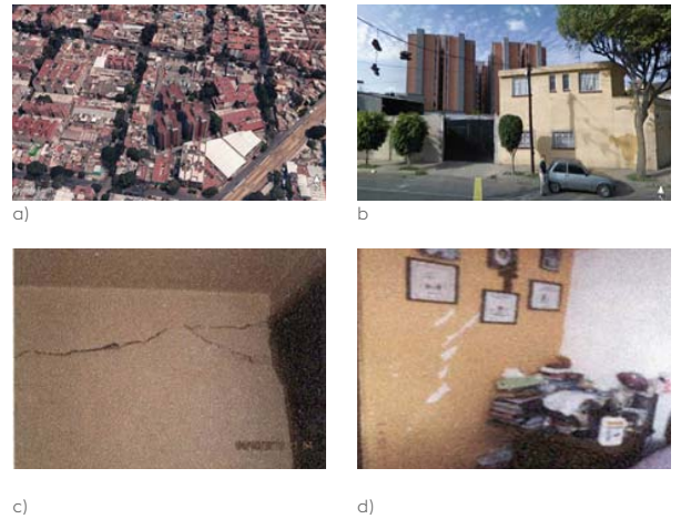
Figura 3.30 Edificio considerado de daño medio: (a) Vista aérea del edificio (Abril 2017) (Imagen obtenida de https://bit.ly/2CxYQVV ), (b) Fachada norte y oriente del edificio previo al sismo (Abril 2017) (Imagen obtenida de https://bit.ly/2CxYQVV ), (c) Grietas existentes en muros (Abril 2018) (Imagen obtenida de: https://bit.ly/2CxYQVV ), (d) años en acabados en muros. (Abril 2018) (Imagen obtenida de: https://bit.ly/2CxYQVV )
