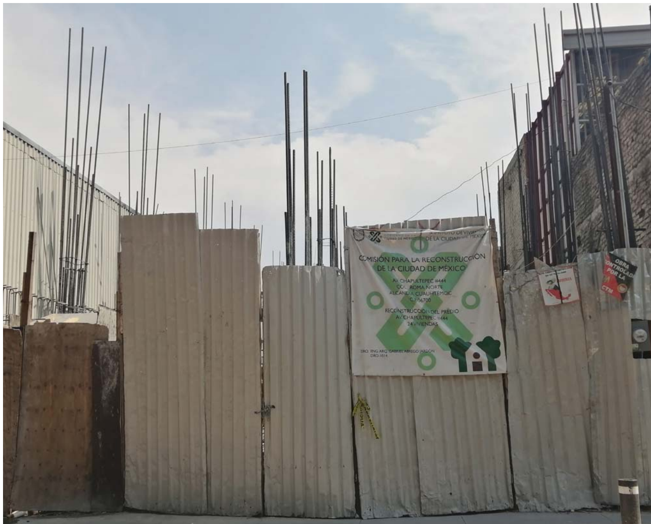
Figura A.13. Edificio en proceso de reconstrucción. Créditos fotográficos: Vania Catalán, Marzo de 2020.
