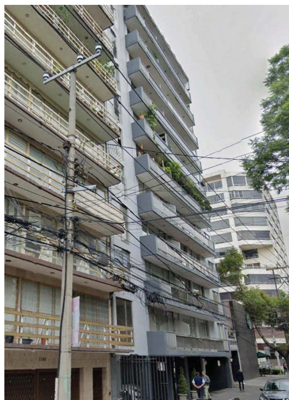
Figura 3.29 Edificio en la colonia Del Valle registrado con daño medio (D2) de acuerdo con la información obtenida de dictámenes y plataformas en línea. Imagen obtenida de Google Earth. Marzo 2020: https://bit.ly/344Go4D
