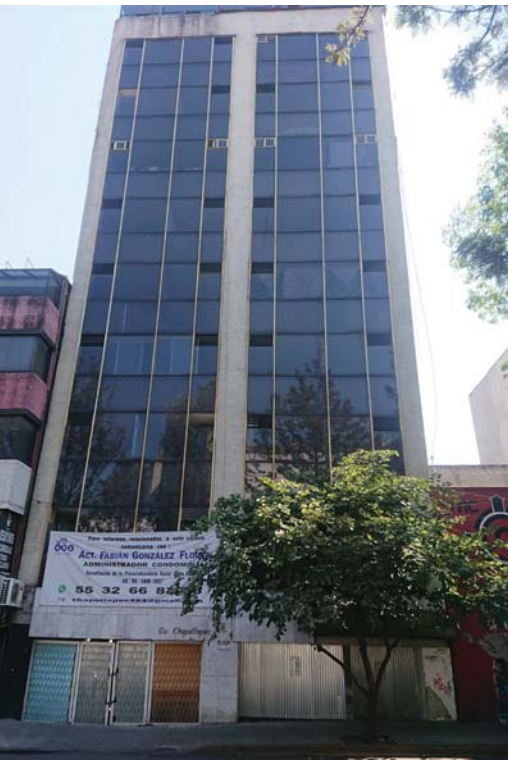
Figura A 17. Edificio deshabitado en espera de proyecto de reestructuración. Vista de fachada. Créditos fotográficos: Vania Catalán, Febrero de 2019.
