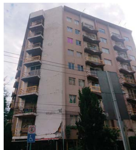
Figura 3.22 Edificio multifamiliar ubicado en la colonia Del Valle, el cual se encuentra en la esquina de Heriberto Frías y Pilares. Créditos fotográficos: Vania Catalán. 28 de marzo de 2019.
