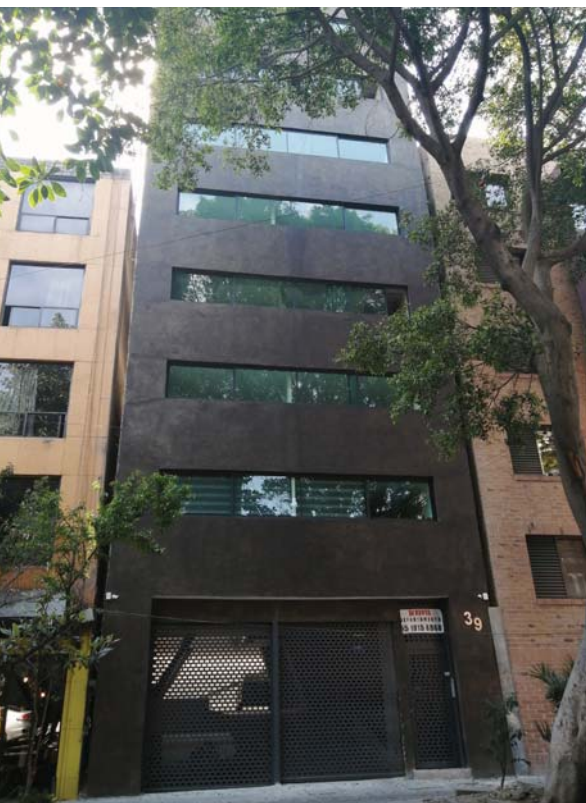
Figura A 27. Edificio rehabilitado completamente y habitado. Estado a dos años y medio del evento sísmico. Créditos fotográficos: Vania Catalán. Marzo de 2020.
