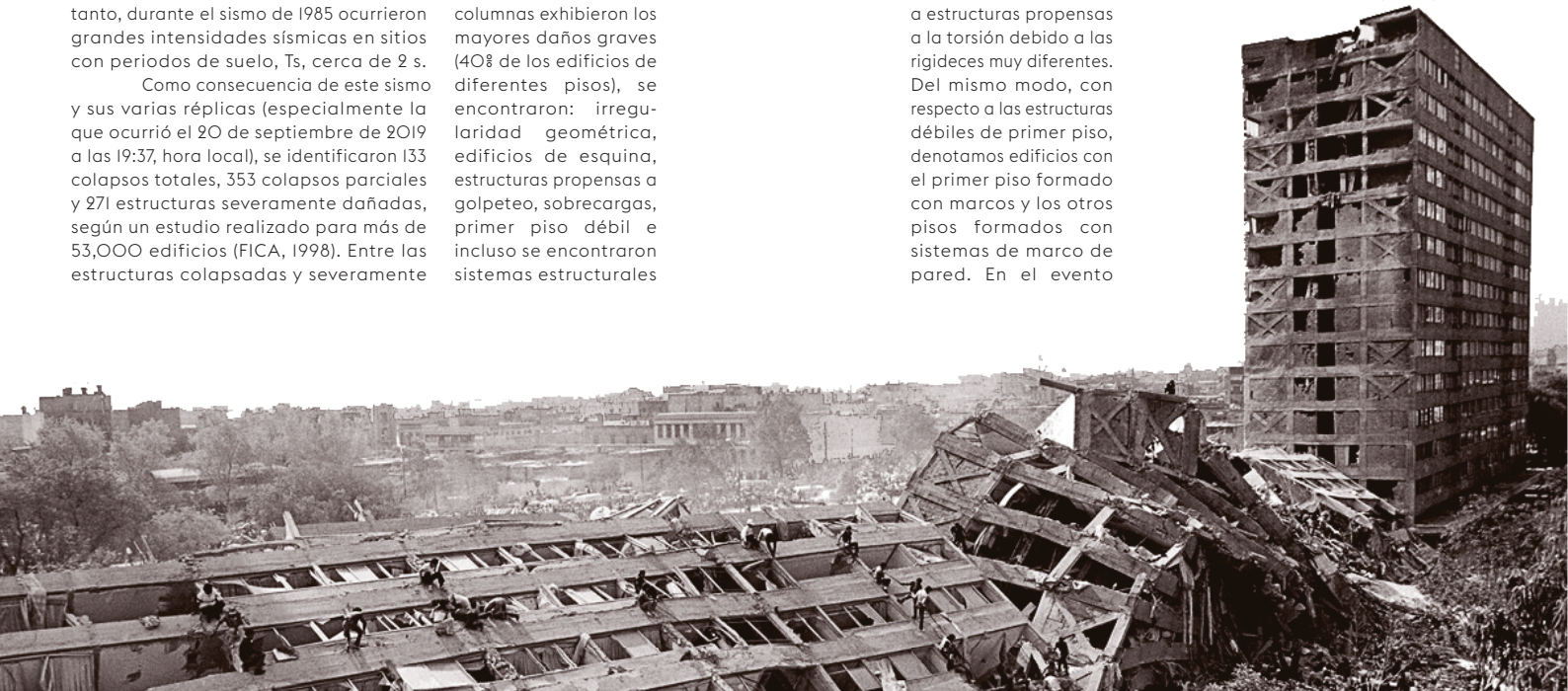
Figura 1.5 Derrumbe de edificios como consecuencia del sismo de 1985. En Tlatelalco, en la imagen el edificio Nuevo León. Créditos fotográficos: Marco Antonio Cruz (Imagen obtenida de: https://bit.ly/2xmtrHr )
