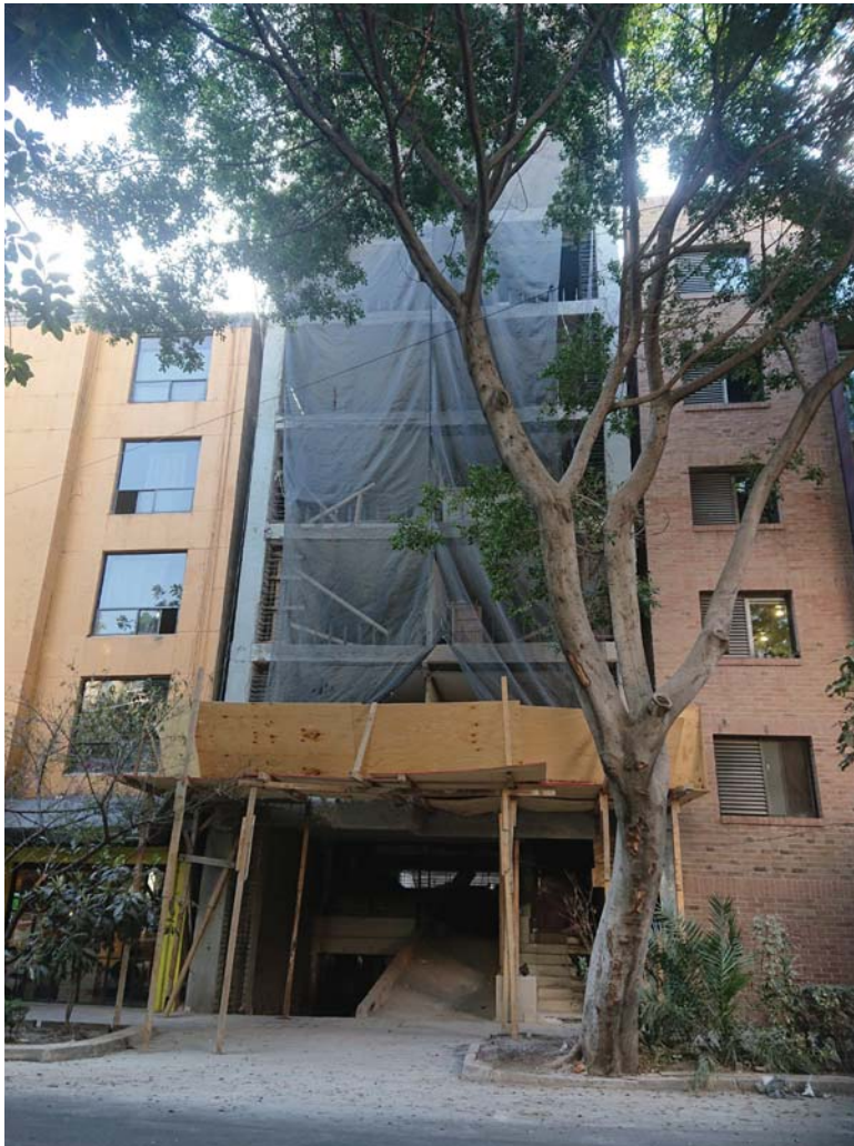
Figura A 26. Estado del proceso de rehabilitación del edificio de vivienda. Créditos fotográficos: Vania Catalán, Febrero de 2019.
