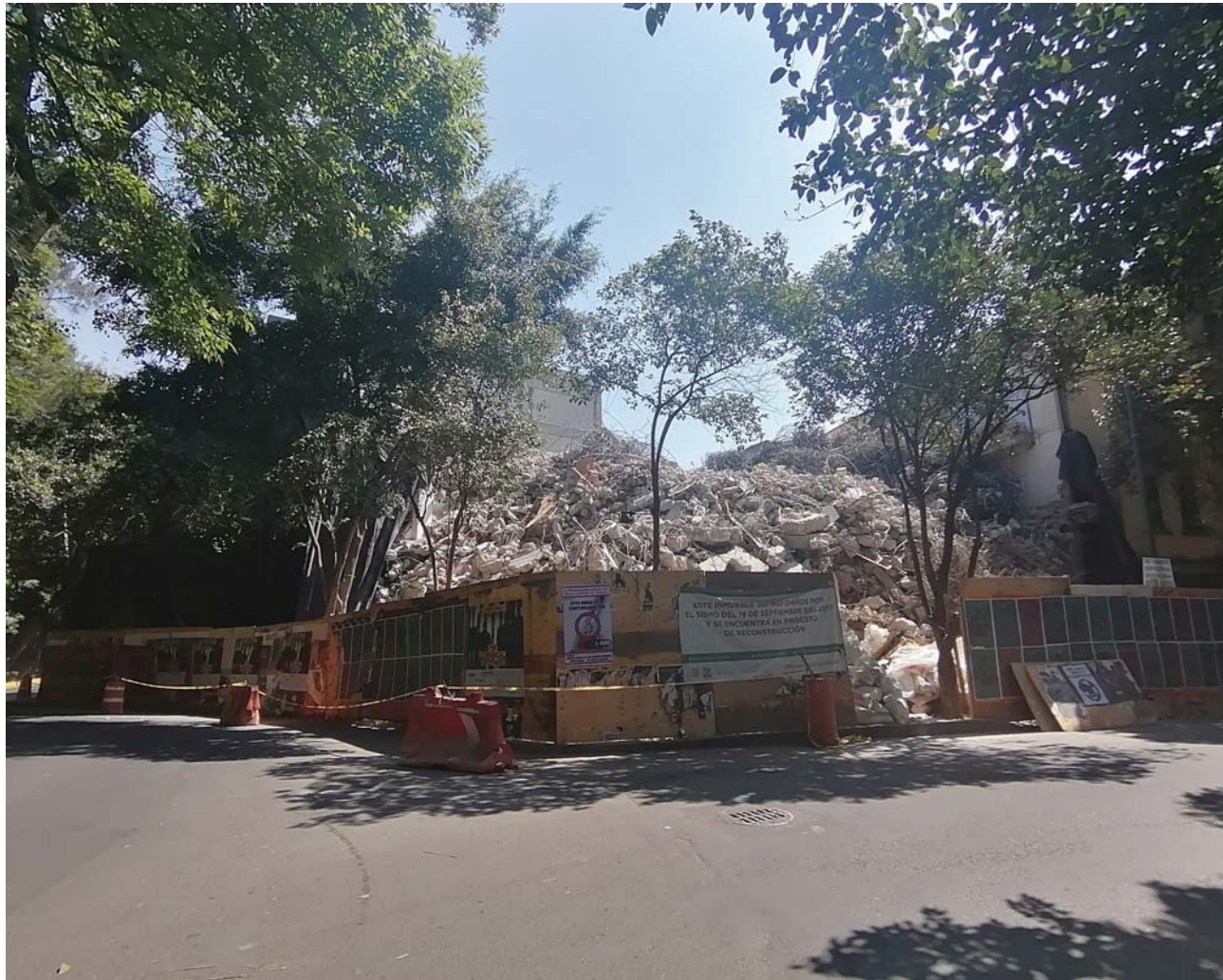
Figura A.5 Trabajos de demolición del edificio. Créditos fotográficos: Vania Catalán, Marzo de 2020.
