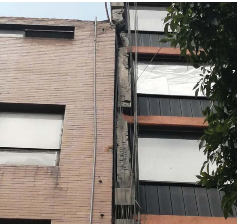
Figura 3.8 Croquis de golpeteo entre edificios de diferentes alturas y que no coinciden sus entrepisos. (Murty, 2004) (imagen obtenida de: https://bit.ly/2HTuDVa )
