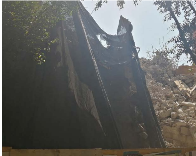
Figura A.6 Trabajos de demolición del edificio. Créditos fotográficos: Vania Catalán, Marzo de 2020.
