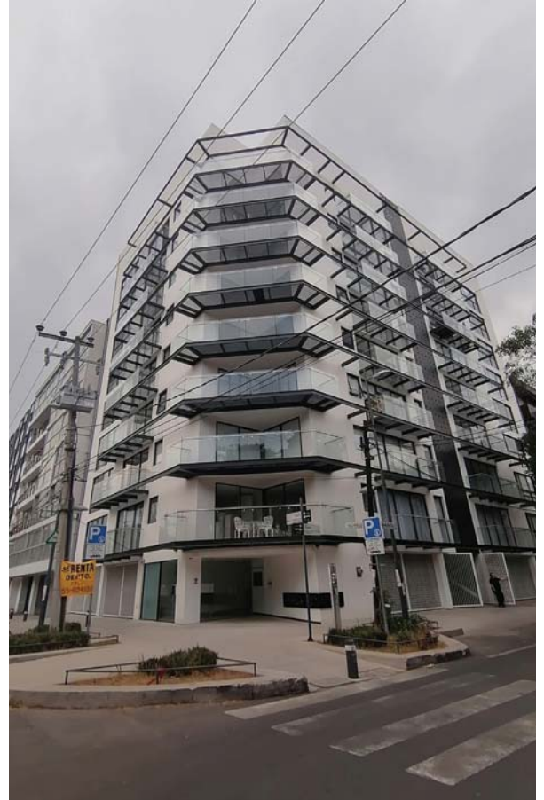
Figura A 55. Edificio rehabilitado y habitado. Créditos fotográficos: Vania Catalán, Marzo de 2020.
