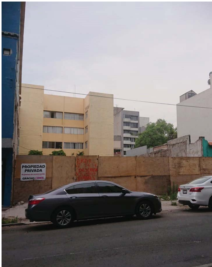
Figura A 60. Edificio demolido. Créditos fotográficos: Vania Catalán, Febrero de 2019.
