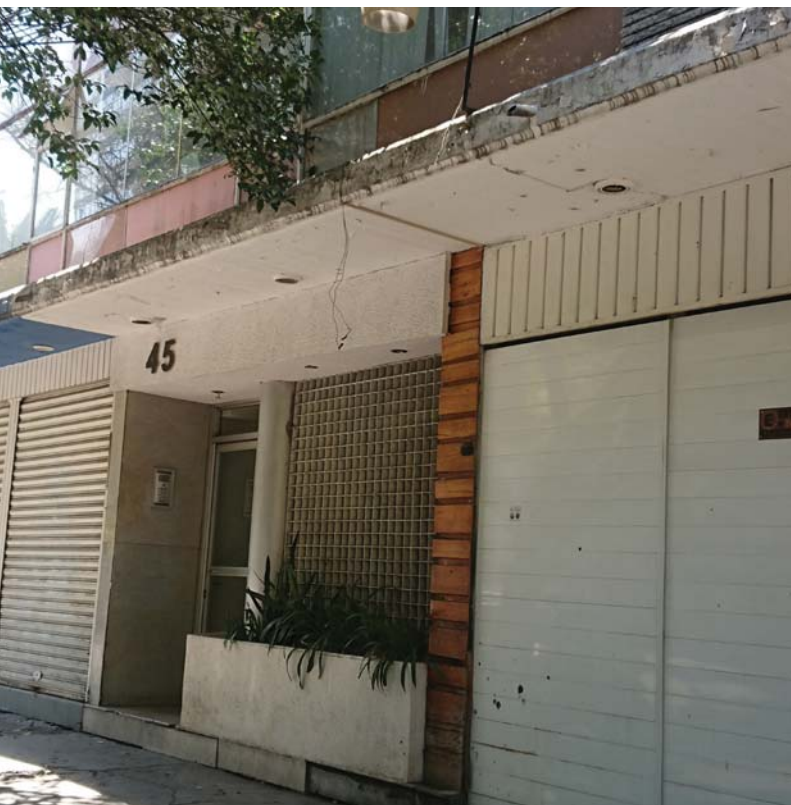
Figura A 24. Acceso vehicular y peatonal. Edificio deshabitado en espera de proyecto de reestructuración. Créditos fotográficos: Vania Catalán, Febrero de 2019
