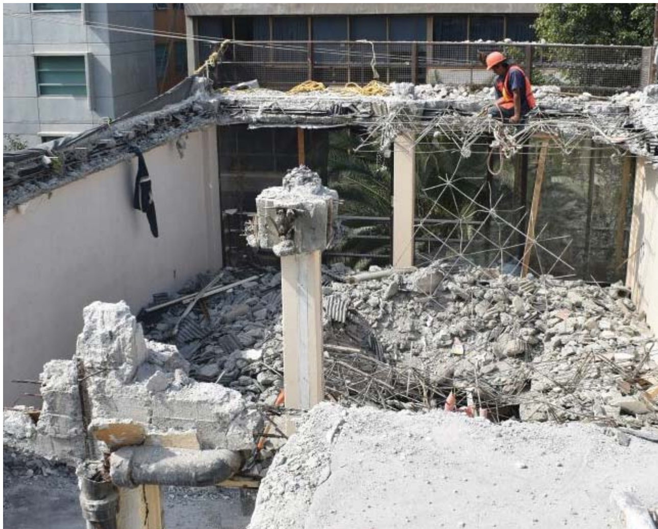
Figura A 48. Trabajos de demolición del edificio. Créditos fotográficos: Secretaría de Obras y servicios. Marzo de 2018. Imagen obtenida de: https://bit.ly/2VpMnNo
