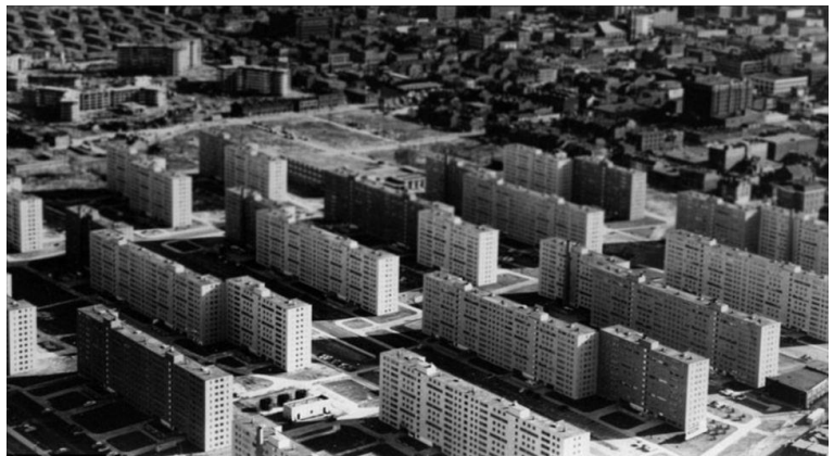
20. Pruitt-Igoe, Missouri, Estados Unidos, 1955. Frame del documental The Pruitt-Igoe de Chad Friedrichs, 2011.
