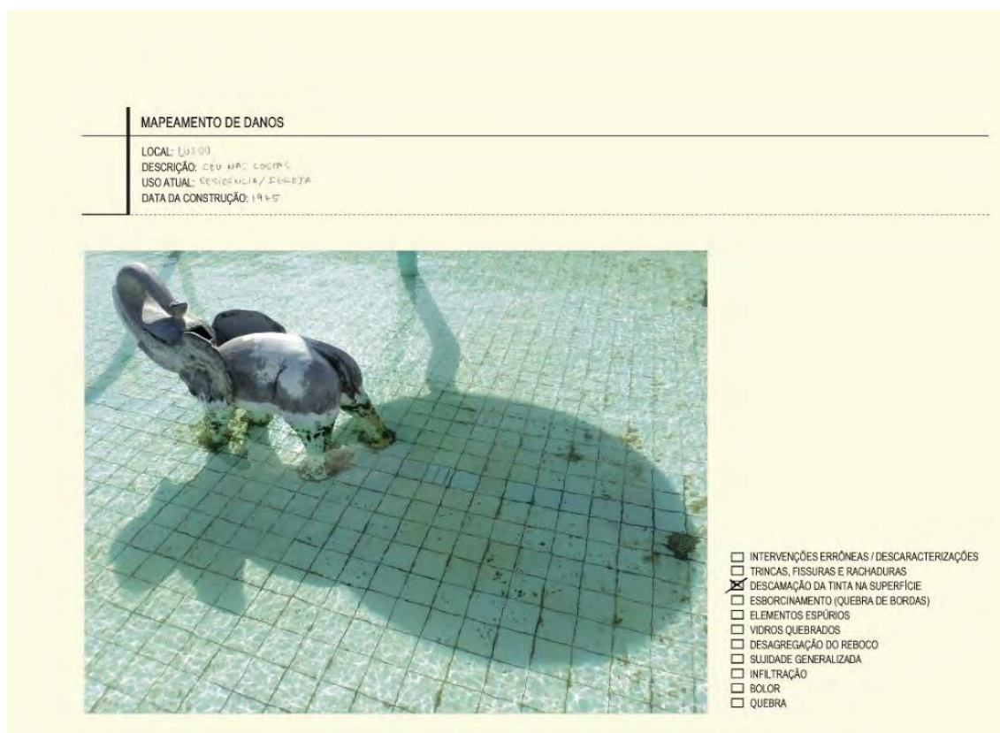
25. Ficha 03. Descrição: céu en las espaldas / patologia: descamación de la pintura. Foto Paulo Vítor Soares.
