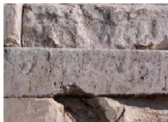
Fig. II.1.2 Capas de piedra cortada y sin mortero para permitir deslizamiento de la Tumba de Ciro el Grande. (Bayraktar, 2012)
