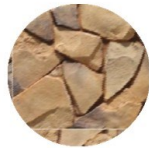
PIEDRA LAJA Utilizada para cubrir de la lluvia los muros de adobe (es sus primeros 90 centímetros) a forma de rodapié.
