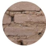
TIERRA CRUDA – ADOBE Utilizado para construir los muros de sus construcciones.
