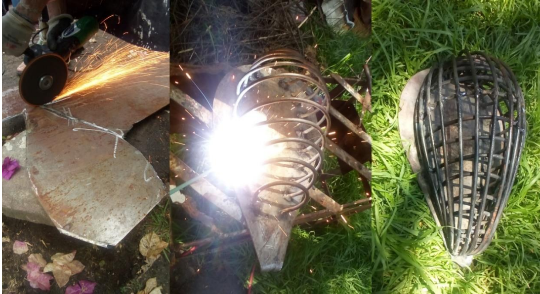
Fig. 152. Proceso de forja, soldeo y armado de estructura metálica. Fotografía de Leticia Arcos, 2019.
