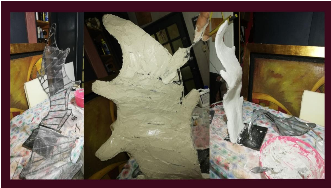
Fig. 187. Recubrimiento con maya metálica y aplicación de la mezcla. Fotografía de Leticia Arcos, 2019.
