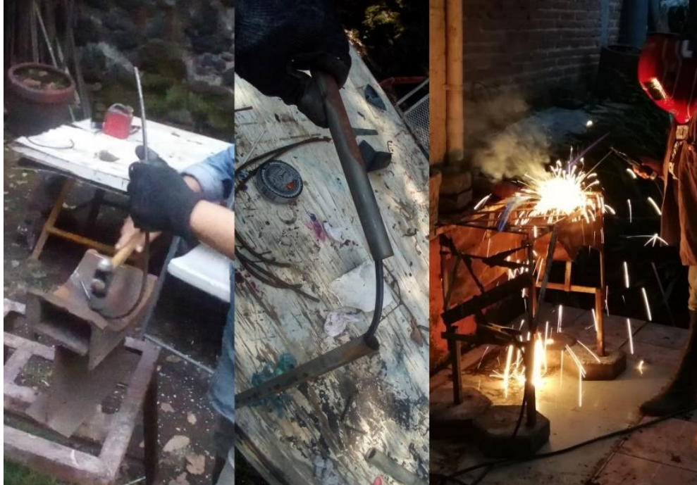
Fig. 185. Proceso de corte. Forja, soldeo y armado. Fotografía de Leticia Arcos, 2019.
