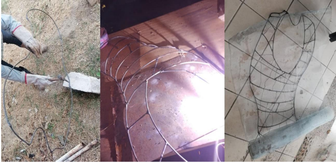
Fig. 147. Proceso de forja, soldeo y armado de estructura metálica para cuerpo de jaguar. Fotografía de Leticia Arcos, 2019.
