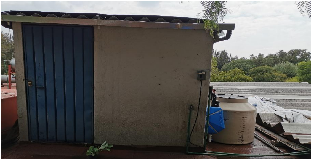
Fotografía 1. Área de captación
