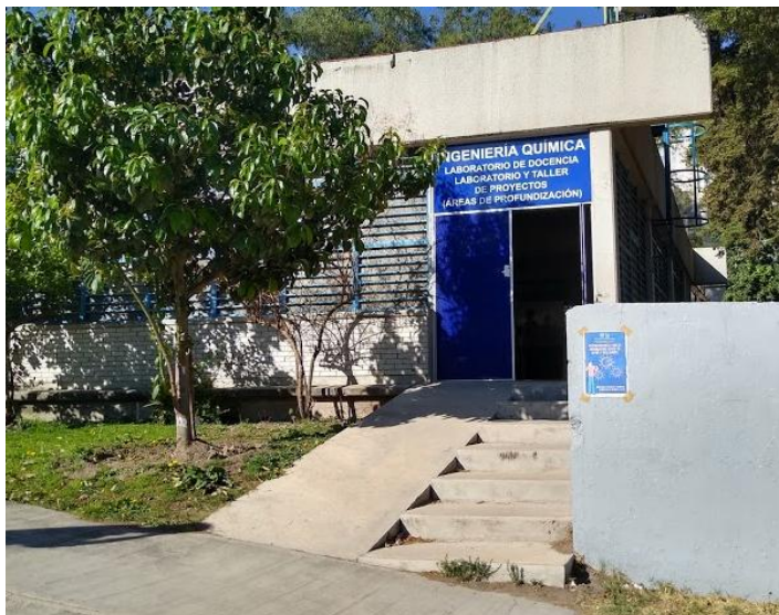
Foto 10, Laboratorio donde se instaló el sistema.
