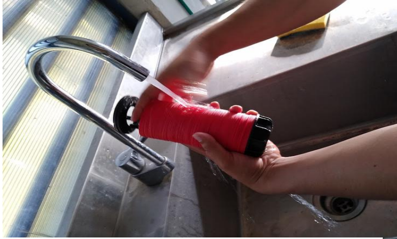
Fotografía 9. Limpieza del filtro de sedimentos.
