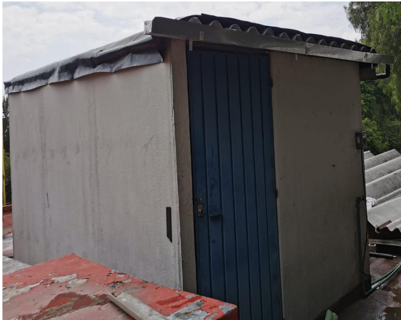
Foto 1. Techo cubierto con la membrana de polietileno.
