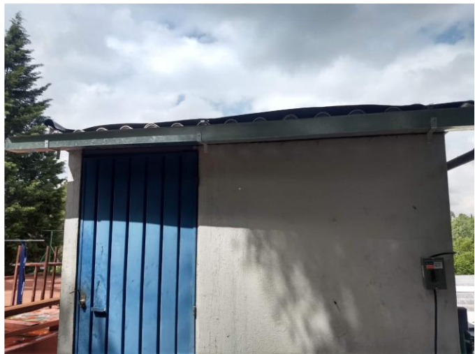
Fotografía 4. Techo y canaleta
