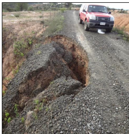
Figura 4.3. Daños en camino por movimientos de masa en el geosendero Los Corazones (Cortesía Oralía Oropeza)
