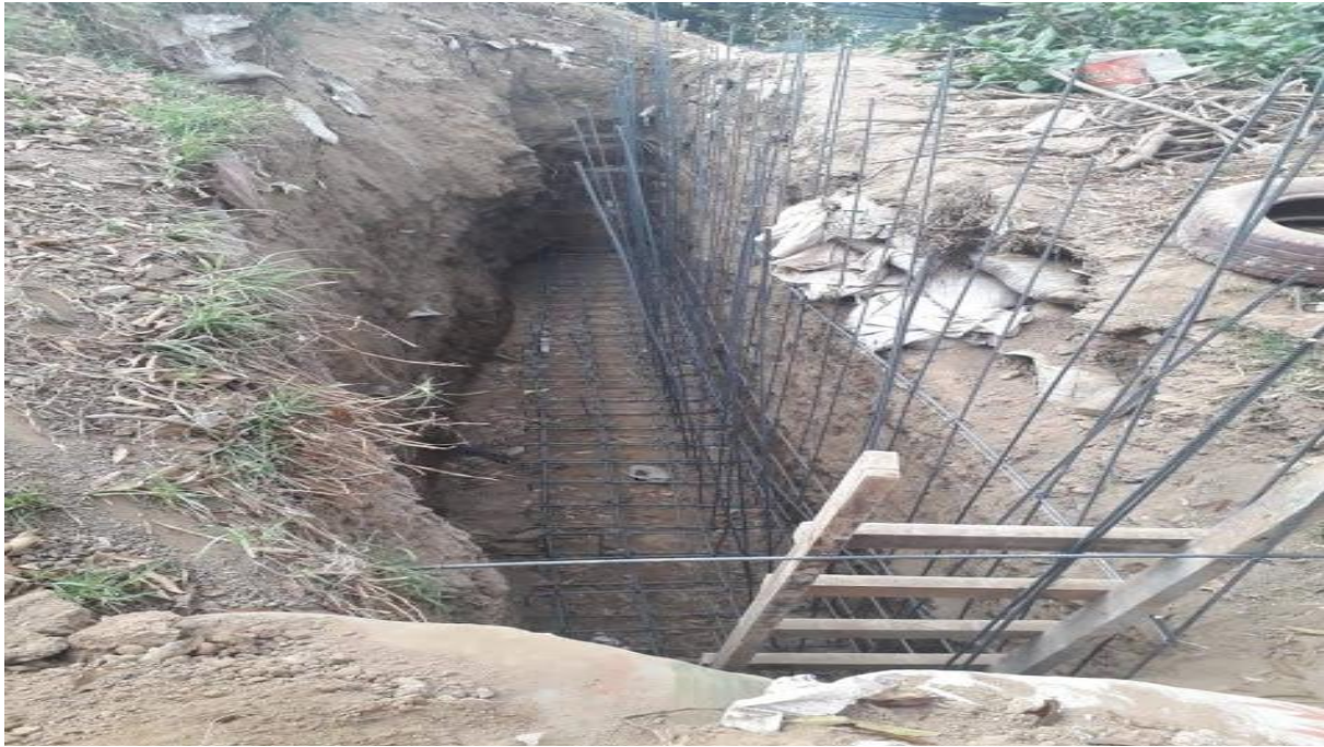
Foto: construcción del primer muro de contención para la cocina comunitaria/González Peña Erika/2020
