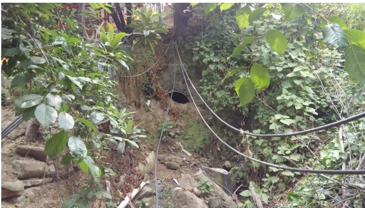
Foto 7: Tubo que se coloca solo cuando se construyen carreteras federales. González Peña Erika /marzo/2019.
