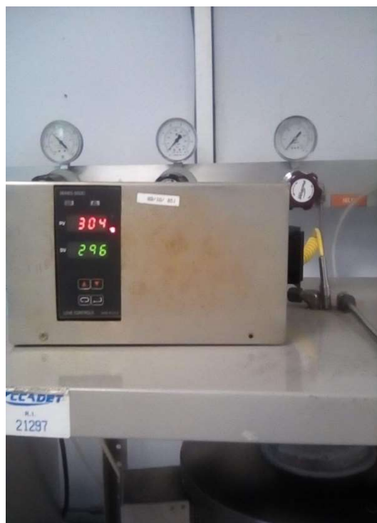
Figura 4.5.2 Panel del programa de temperatura del tratamiento térmico.
