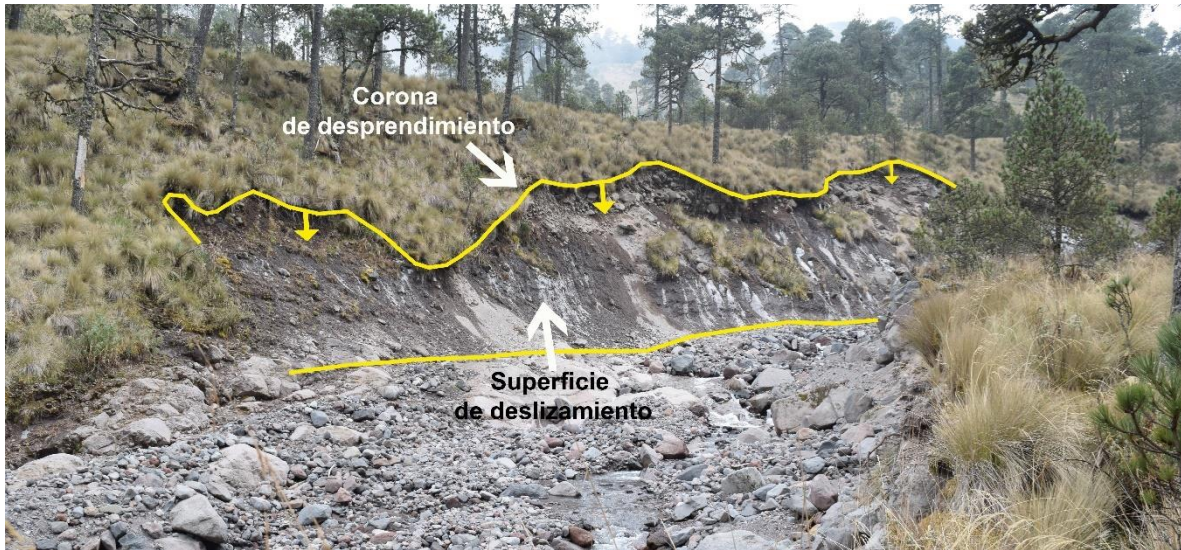
Figura 4.7. Deslizamiento en la ladera piroclástica E del sector B de la barranca Jamapa producto de la inestabilidad de los materiales y del constante paso de detritos que erosionan la superficie favoreciendo su remoción.
