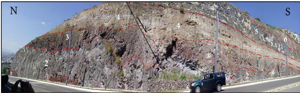
*Figura IV.17. Afloramiento del sitio del Centro de congresos con dirección N-S. El espesor máximo del afloramiento es de 27 m. Los números representan el número de estrato en las descripciones.*
