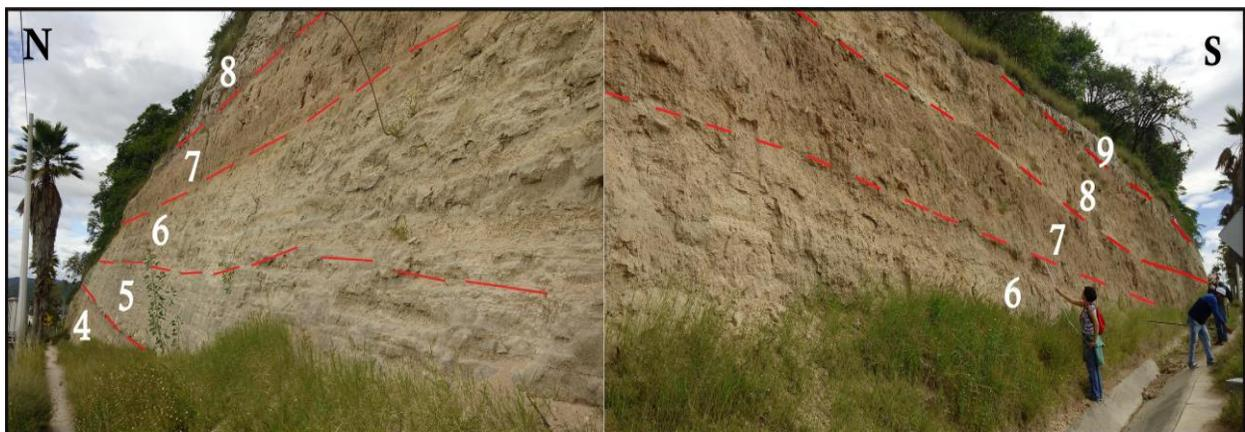
Figura IV.13. Afloramiento sobre la avenida Blvd. de la Nación con un espesor de 112 m. Los números representan el número de estrato en las descripciones.
