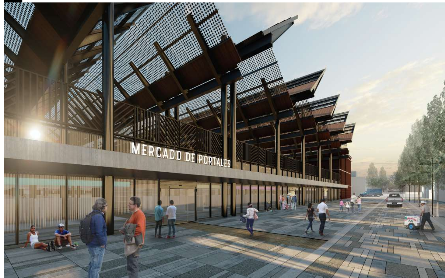
B Fachada este. El mercado está concebido como un volumen permeable espacial y visualmente, y con una relación más estrecha con el exterior. Por ello el volumen presenta una solución cubierta y abierta, en donde predominan los materiales traslúcidos como el policarbonato, el vidrio y las celosías de herrería.
