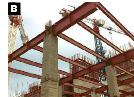
Sistema de construcción híbrido concreto-acero. *https://www.bca.gov.sg/
