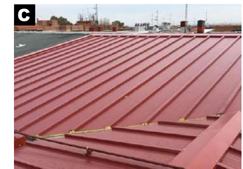
Sistema de panel sandwich para cubierta. *https://impertecsl.com/rehabilitacion-tejadros/
