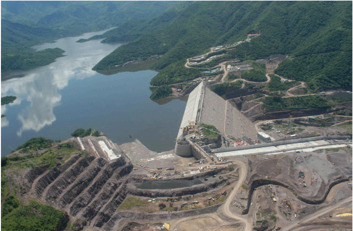
Figura 12. Panorámica de la presa El Cajón.
